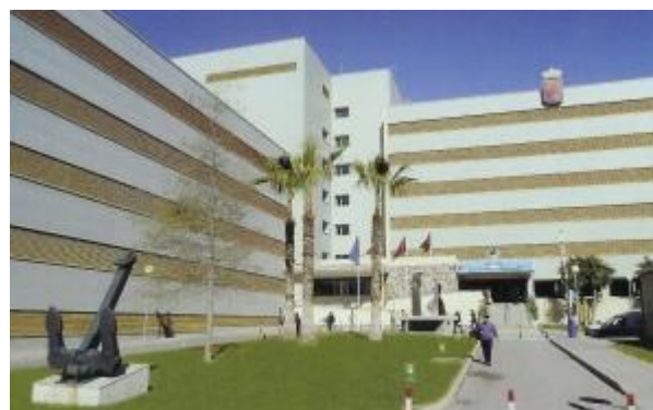
Ilustración 34. Fachada Hospital Rosell. Cartagena.
