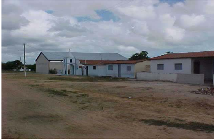
Figura 15 – Povoado de Lagoa Doce (escola, igreja e ginásio poliesportivo) – Guamaré..
