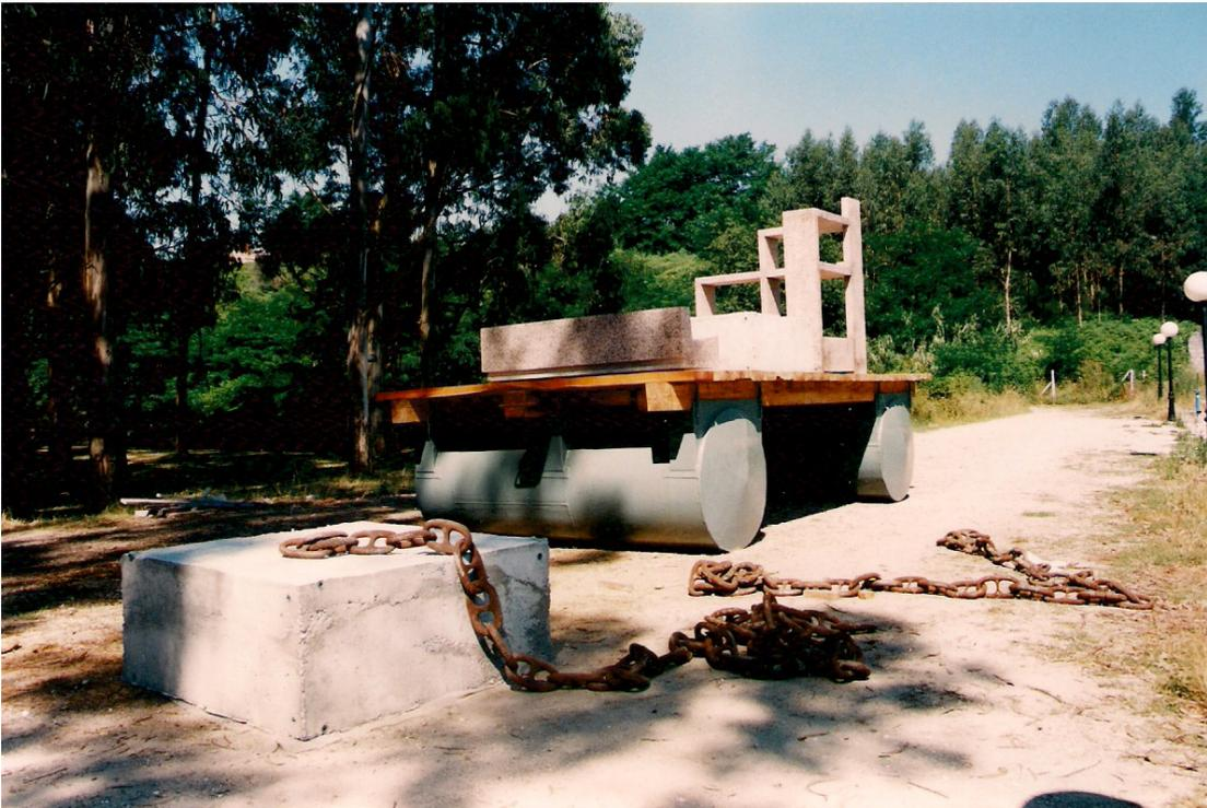
*Montaje de la plataforma y colocación de la estructura de granito encima, para fondearlo después en el río Lérez.*
