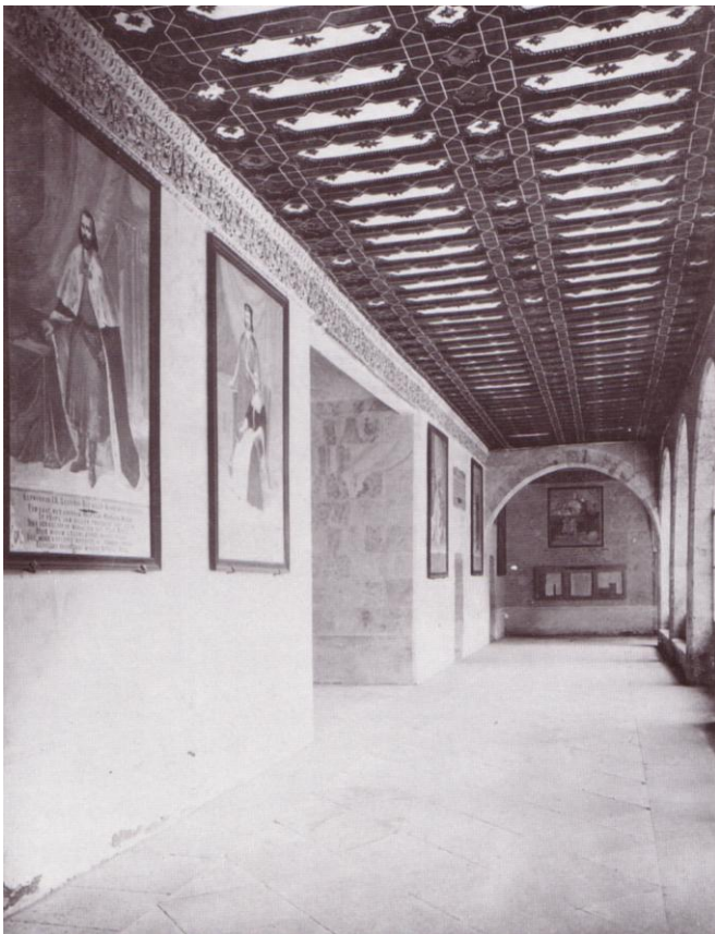
Foto del claustro bajo con mezcla de varios lienzos en la pared del lado oeste y con un fresco en la del lado norte (al fondo de la imagen). Jean Laurent, 1857
