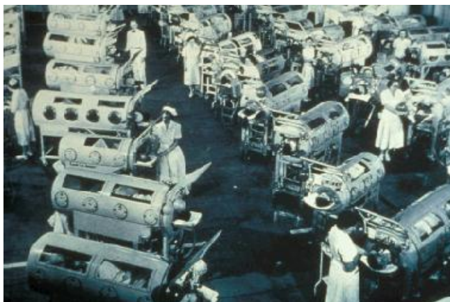
Figura 4. Salas con respiradores de presión negativa
