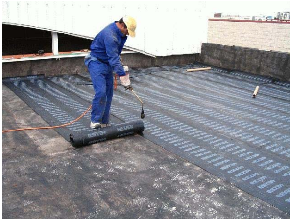
Membrana asfáltica sobre azotea
