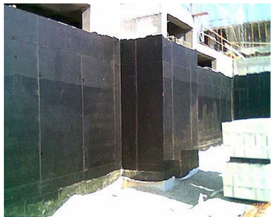
Impermeabilización muro con pintura asfáltica
