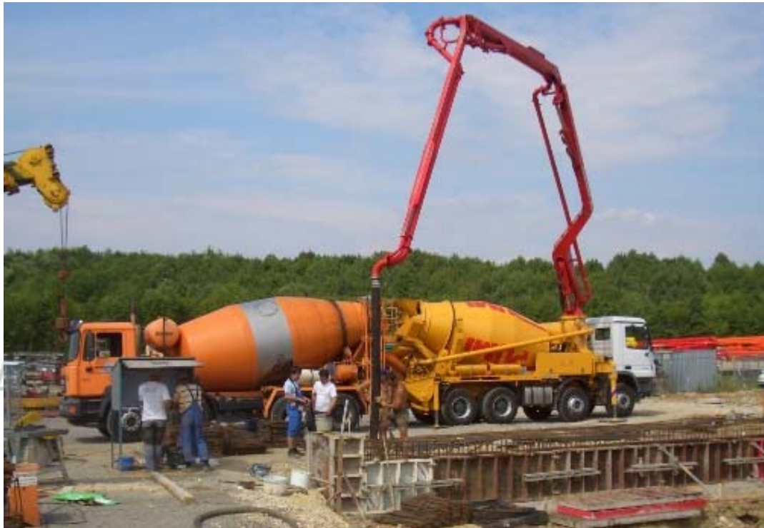
Camión bomba de hormigón
