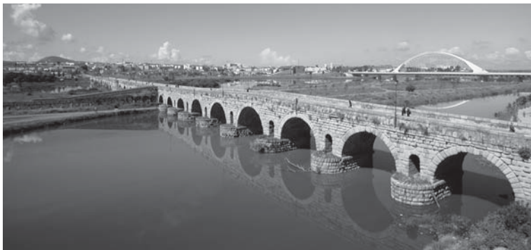
Fig. 3 A) Vista actual general del puente sobre el Guadiana, foto: archivo MNAR, C. López.
