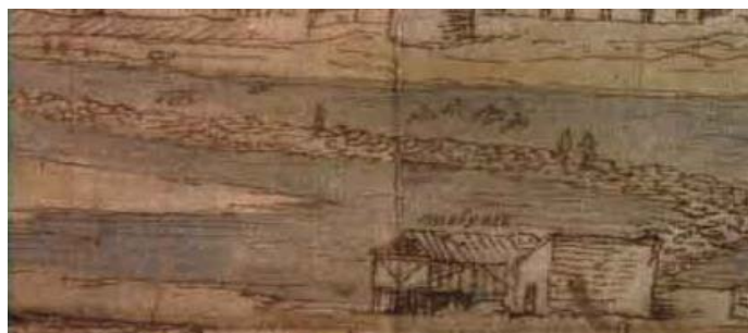
Presa y molino sobre el río Tormes, fragmento de la vista de Salamanca realizada por Antón Van den Wyngaerden
