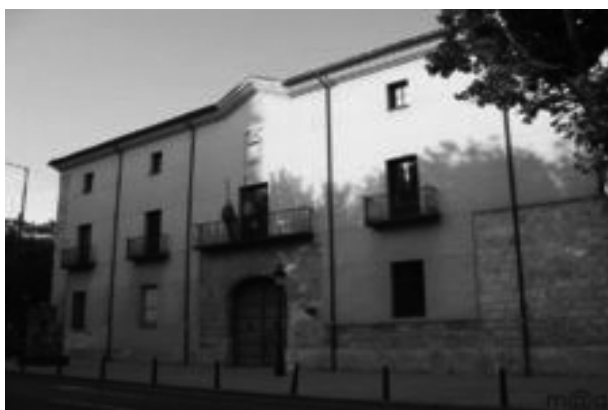
Fachada del Archivo de la Real Chancillería de Valladolid
