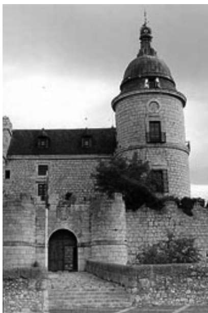
Fachada del Archivo General de Simancas
