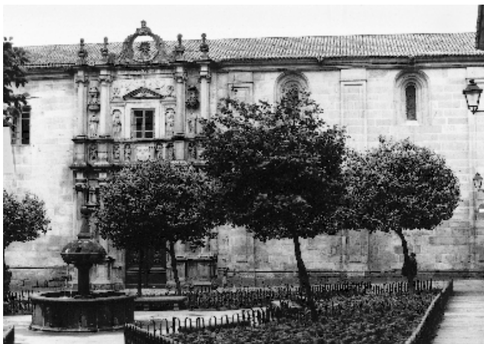
FIG. 228. Santiago de Compostela. Colegio Fonseca. Fachada principal.
