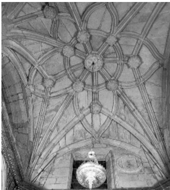
FIG. 103. Santiago de Compostela. Catedral. Bóveda de la Capilla de Mondragón.
