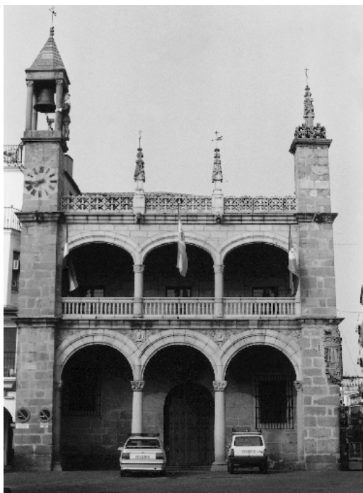
FIG. 244. Plasencia. Ayuntamiento. Fachada.
