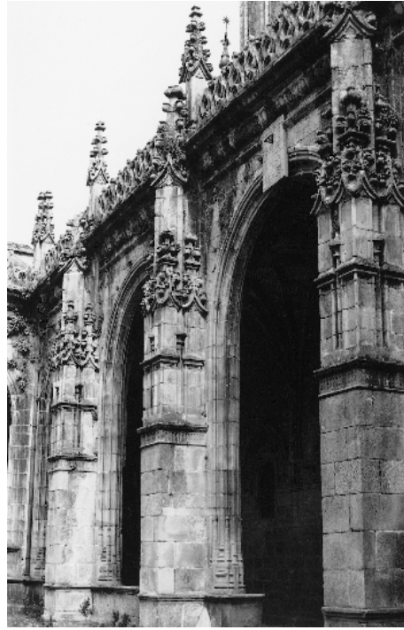
FIG. 92. Santiago de Compostela. Catedral. Contrafuertes del claustro.
