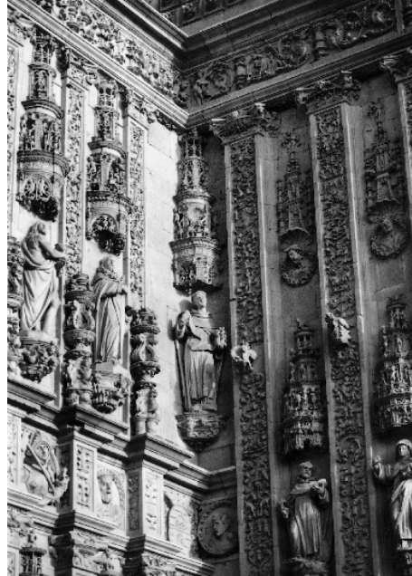
FIG. 176. Salamanca. San Esteban. Fachada. Detalle del segundo cuerpo.
