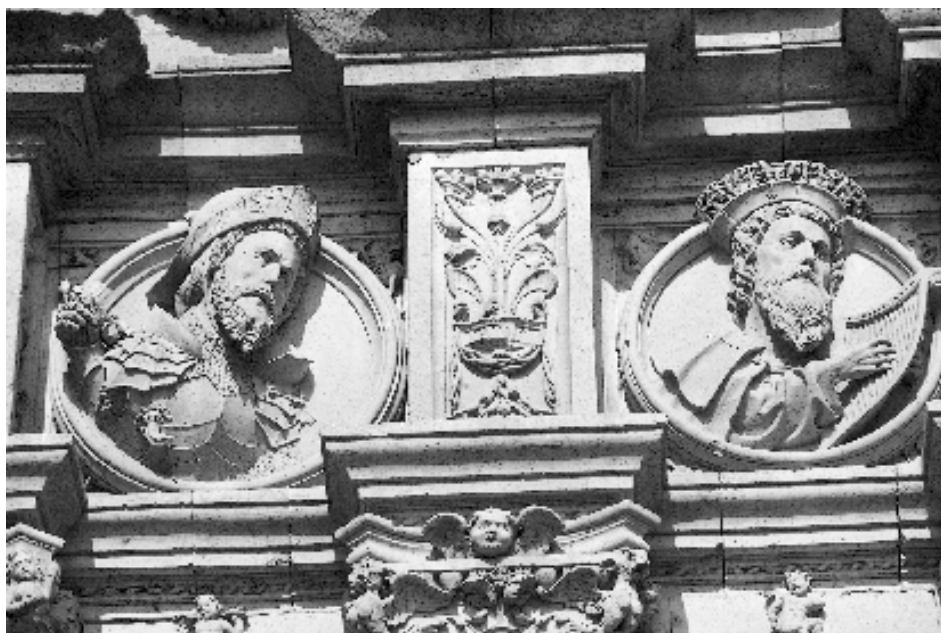
FIG. 54. Salamanca. San Esteban. Medallones del friso del primer cuerpo de la fachada.
