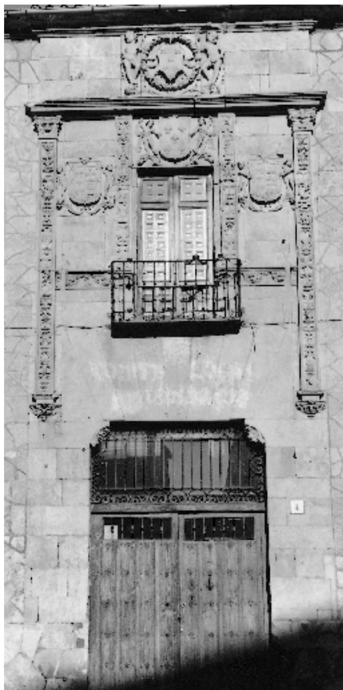
FIG. 66. Salamanca. Casa de Diego Maldonado. Fachada.
