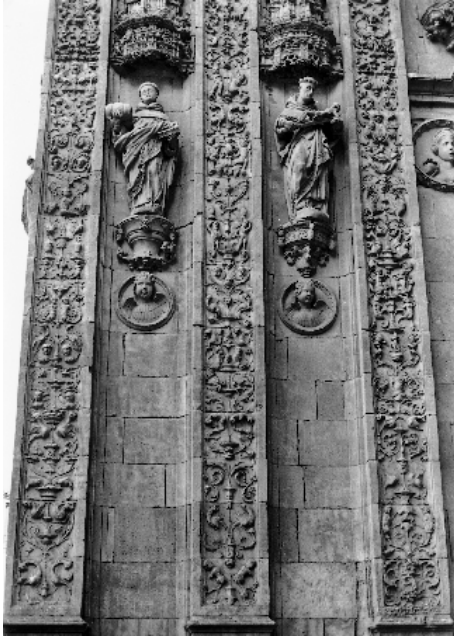
FIG. 175. Salamanca. San Esteban. Fachada. Detalle del contrafuerte izquierdo.
