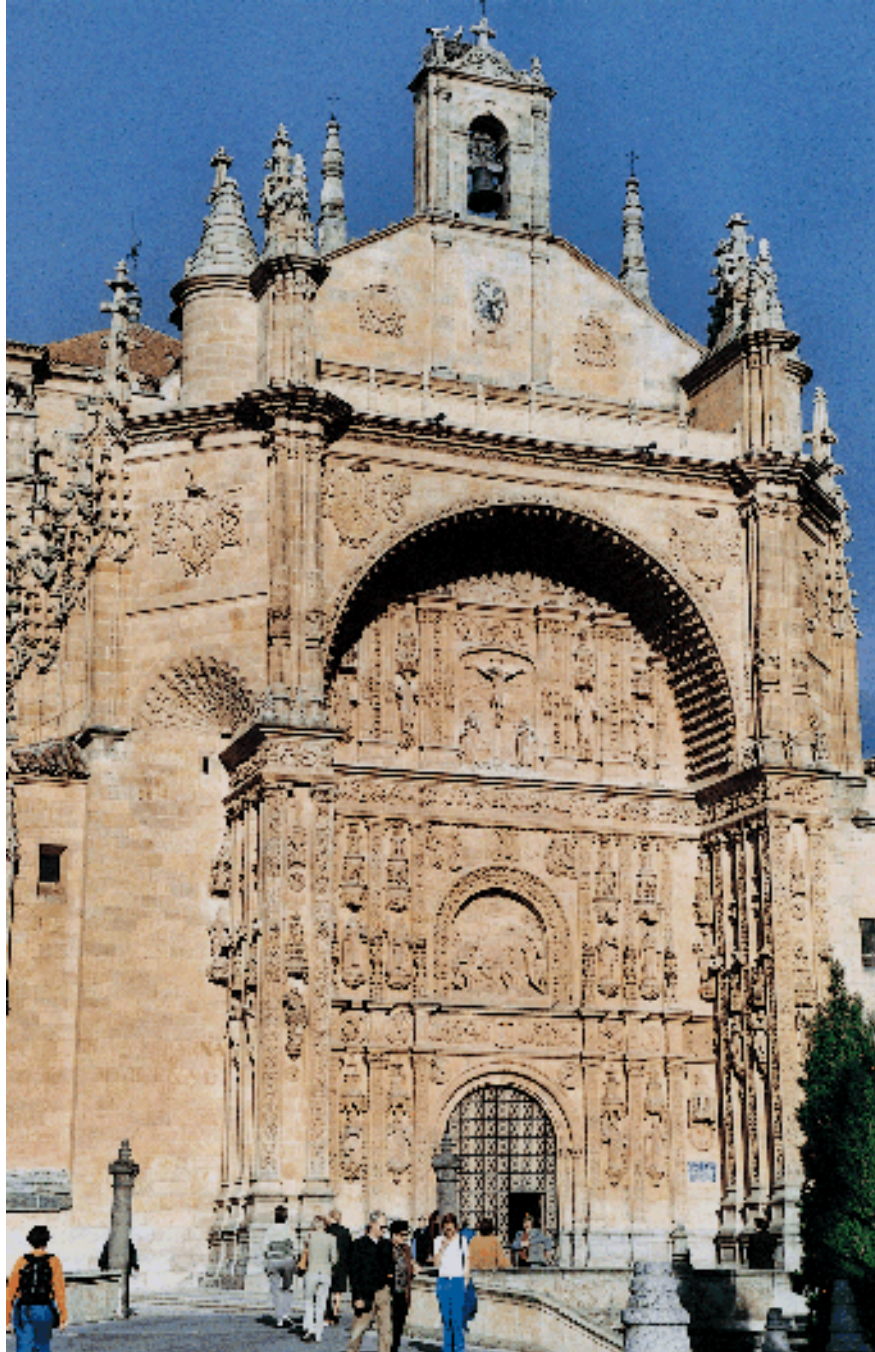
LÁM. 20. Salamanca. San Esteban. Fachada.
