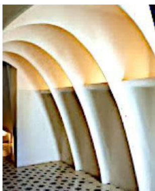
Fig. 186. Arcos catenarios en la buhardilla de la Casa Batlló. Fuente: GIRALT-MIRACLE, D. Gaudí. La búsqueda de la forma... , p. 34.
