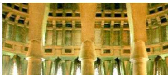
Fig. 197. Capiteles hiperbólicos del Palacio Güell. Fuente: GIRALT-MIRACLE, D. Gaudí. La búsqueda de la forma... , p. 83.
