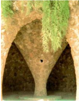
Fig. 198. Bóveda hiperbólica para el giro de carruajes de la entrada del Parc Güell. GIRALT-MIRACLE, D. Gaudí. La búsqueda de la forma... , p. 114.
