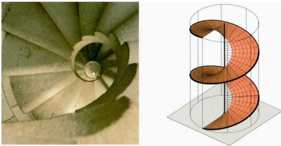
Fig. 64. Escalera de caracol en una torre del templo de la Sagrada Familia y Modelo geométrico de escalera de caracol. Fuente: GIRALT-MIRACLE, D. Gaudí. La búsqueda de la forma... , p. 95.
