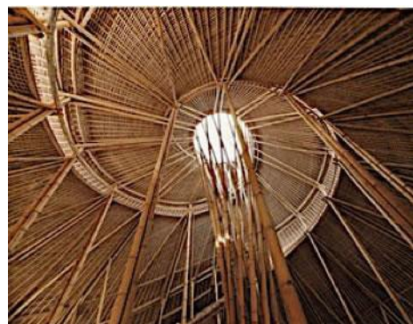
Fig. 150. Estructura de la techumbre de la Green School. Fuente: PT BAMBOO PURE, "Bucles de bambú. Campus y escuela Green School, Bali (Indonesia)". Arquitectura Viva , N.º 137, 2011, p. 53.
