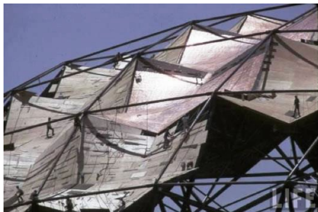
Fig. 214. Proceso de construcción de los paraboloides hiperbólicos con planchas de cobre. Fuente: https://www.plataformaarquitectura.cl/cl/02-331368/clasicos-de-arquitectura-palacio-de-los-deportes-felix-candela .
