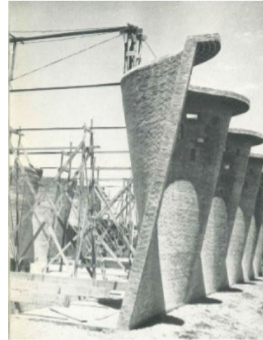
Fig. 175. Perfil sinuoso de la pared de la iglesia La Atlántida. Fuente: https://www.architectural-review.com/archive/church-atlantida-uruguay-by-eladio-dieste .
