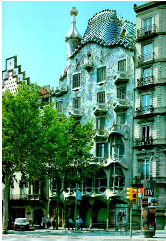
Fig. 156. Fachada principal de la casa Batlló. Fuente: ESTÉVEZ, A.T. Gaudí ... , p. 51.
