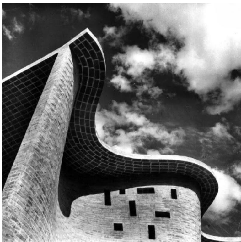
Fig. 173. Movimiento ondulante en las paredes y techo de la iglesia La Atlántida de Dieste. Fuente: http://arquitecturazonacero.blogspot.com/2013/10/eladio-dieste-escritos-y-obras-1943-1996.html
