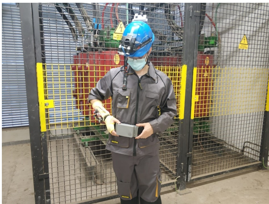
FIGURA 3.32: Operario configurando el cinturón en un centro de transformación.
