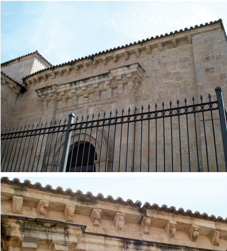
(Fig. 09) Iglesia de San Cristóbal. Estado actual.
