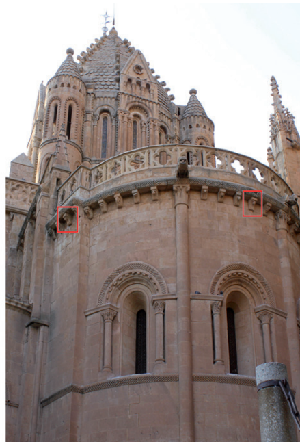
(Fig. 04) Estado actual, exterior de la Catedral Vieja.
