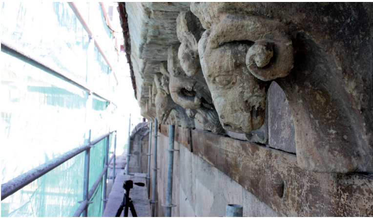
(Fig. 24). San Juan de Barbalos. Cornisa meridional durante la restauración efectuada en julio de 2010.
