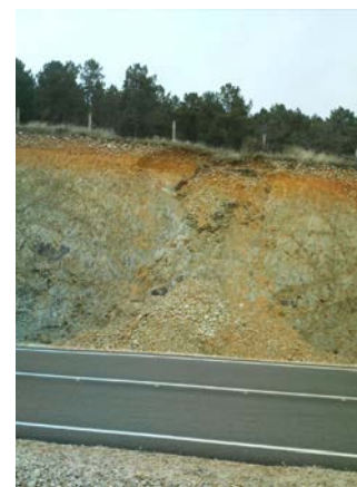
Figura III 4.1 -34. Desprendimientos de talud. Monsagro (Izq.). Deslizamiento rotacional en perfil de alteración en El Maillo. (Dcha).
