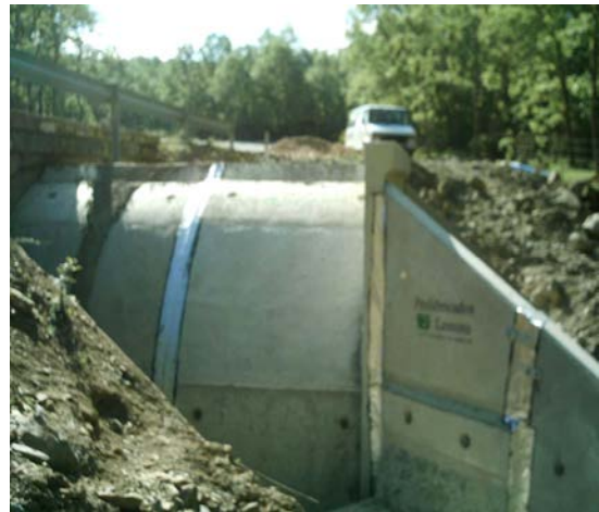
Figura III 3 -81. Canalización para el drenaje bajo puente atravesando río Yeltes. El Maillo.
