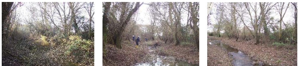
Figura III 3 -71. Secuencia fotográfica de las tareas de limpieza del cauce del río Gavilanes, afluente del río Yeltes a su paso por la localidad de Santi-Spiritus. Izq. Cauce con malezas; Centro: tareas de acondicionamiento y limpieza; Dcha: cauce limpio.
