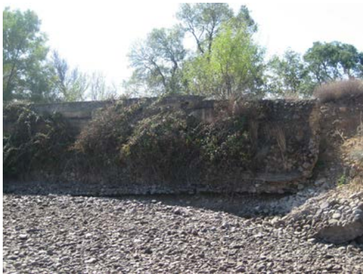
Figura III 3 -75. -a- Izq: Muro de contención que deriva la corriente del río Yeltes hacia el margen derecho. Alba de Yeltes. -b- Dcha: Muro de contención formado por acopio de gravas, paralelo al cauce. Alba de Yeltes.
