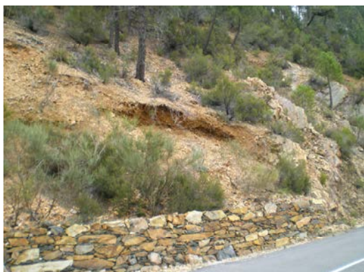
Figura III 4.1 -15. Ladera vegetada, con deslizamientos superficiales con orientación al sur, en el valle de Las Batuecas.
