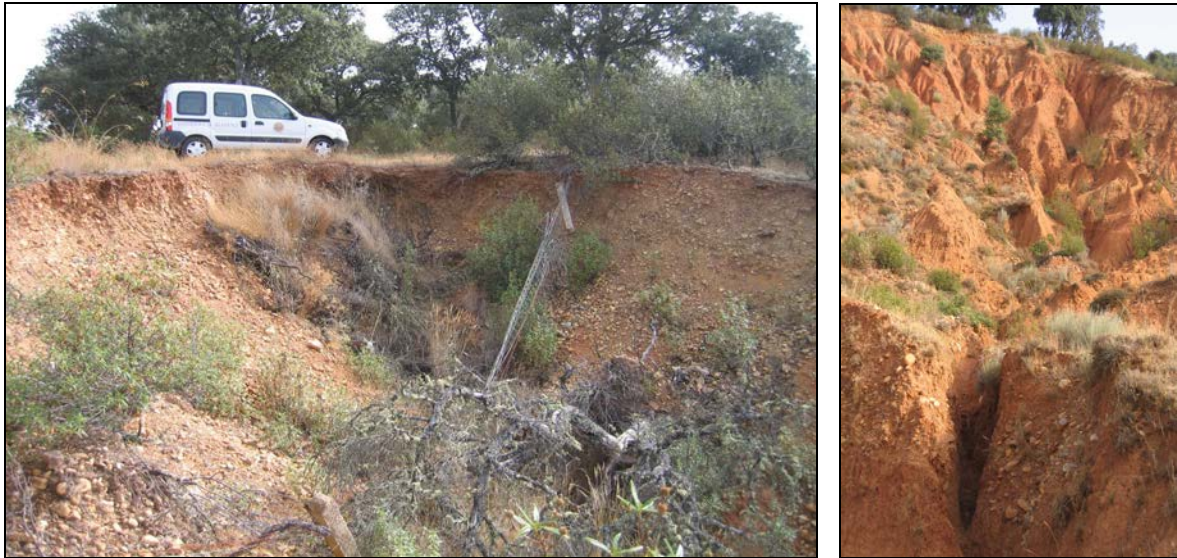
Figura III 2,1 -7. Barranco generado en frente de escarpe, a favor de aguas de arroyada concentradas, provocando el desplome de la superficie del terreno con encinas y vallado por retroceso debido a erosión hídrica. Aldehuela de Yeltes.
