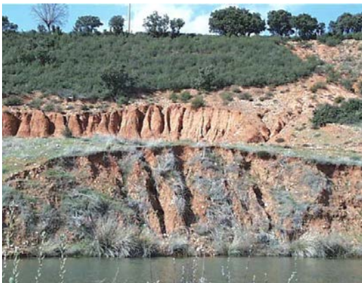
Figura III 4.1 -11. Inestabilidad de ladera provocada por erosión lateral fluvial y favorecida por saturación hídrica de los materiales terciarios. Alba de Yeltes.
