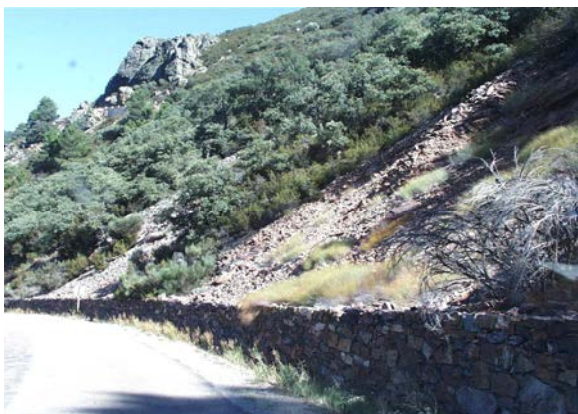
Figura III 4.1 -32. Izq. Canchales deslizando a favor de ladera, y superando los muros de contención de la carretera. Valle de Las Batuecas. Dcha. Deslizamientos superficiales sobre sustratos calizos. Rinconada de la Sierra.
