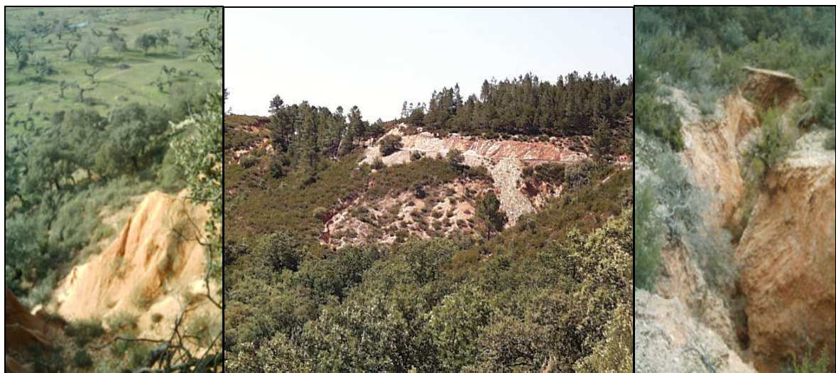
Figura III 2,1 -8. Izq: en zonas con topografía escarpada, se generan formas erosivas (surcos, cárcavas, barrancos), que pueden afectar a infraestructuras humanas: carreteras... (Imagen centro). Dcha: cárcava de 2 m profundidad. Monsagro.
