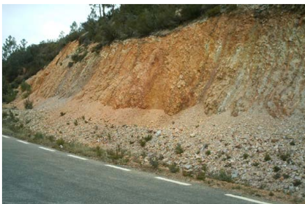
Figura III 4.1 -34. Desprendimientos de talud. Monsagro (Izq.). Deslizamiento rotacional en perfil de alteración en El Maillo. (Dcha).
