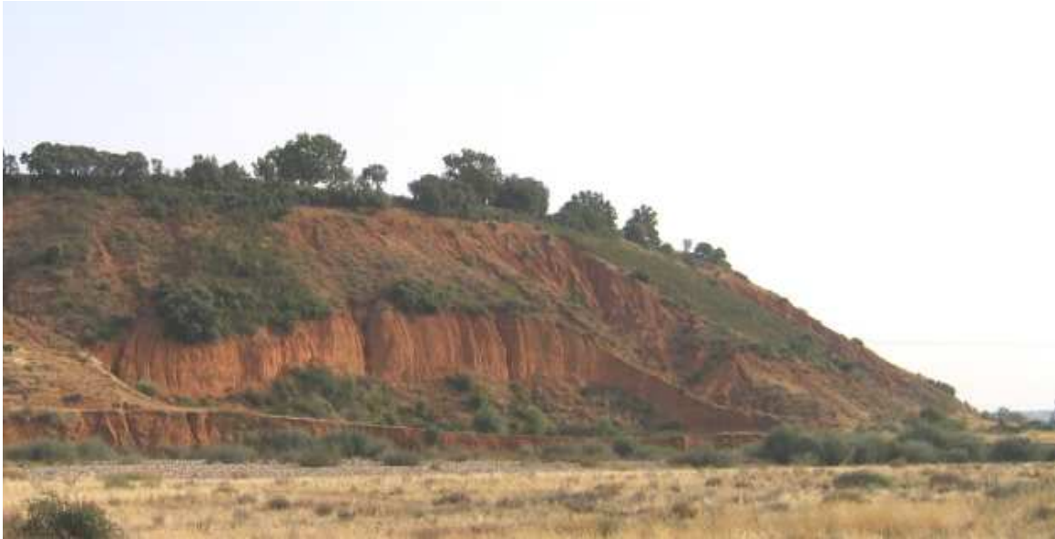
Figura III 4.1 -10. Deslizamiento Rotacional en materiales cenozoicos, por zapamiento fluvial. Obsérvese el escarpe principal, parcialmente tapizado en la base por derrubios. Alba de Yeltes.
