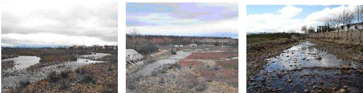
Figura III 3 -70. Imagen del arroyo Moravieja a su paso por la localidad de Alba de Yeltes, cauce desbordado (Izq), y cauce canalizado, con construcción en el margen izquierdo de un dique (centro y Dcha).
