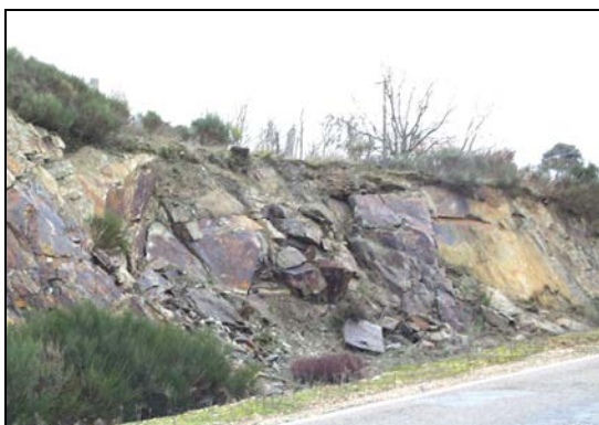
Figura III 4,1 -37. Rotura planar en talud de cuarcita. Pastores.
