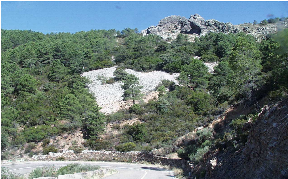
Figura III 4.2-22. Muros de contención que impiden el avance de canchales sobre la carretera del valle de Las Batuecas. El avance es máximo en los cortes de carretera con los valles de alta pendiente.
