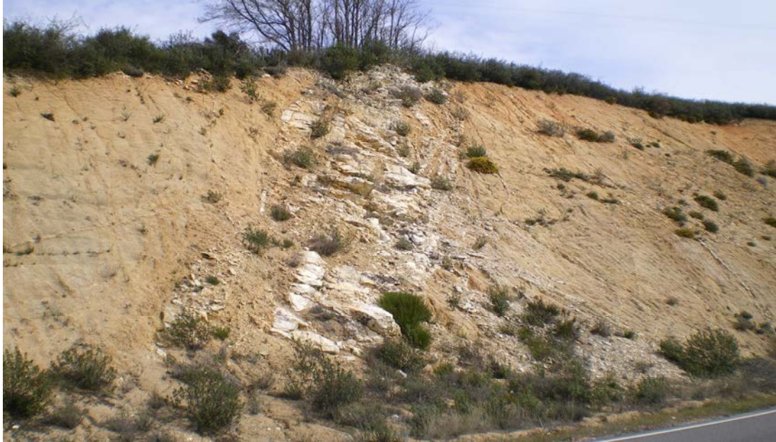
Figura II 2 -7. Intrusión de dique de cuarzo en masa granítica muy meteorizada. San Esteban de la Sierra.
