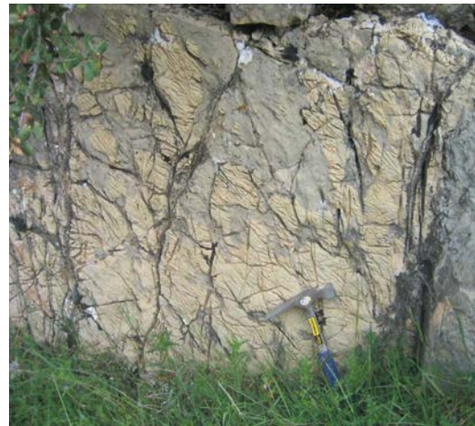
Figura III 4.2 -11. Surcos que provocan una apariencia alteración importante en la superficie de la caliza, por procesos de disolución.
