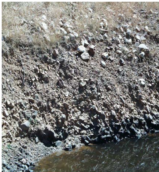
Figura II 4 -3. Suelos con Gleizaciones prof > 0.5-0.m. Nivel freático entre 1 y 2.5 m. en año seco. Dios le Guarde- Aldehuela Yeltes.
