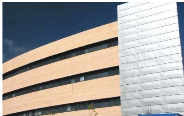
Figura 02. Hospital Sanitas La Moraleja, obra del estudio Berna 10
