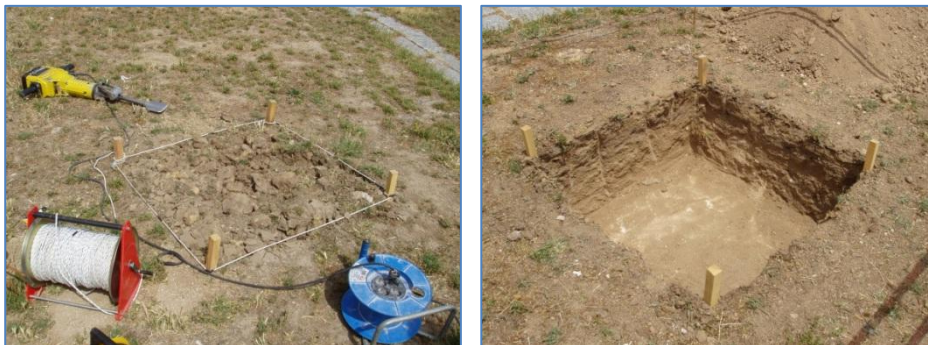
Figura 9. - Excavación para la cimentación de los pilares.
