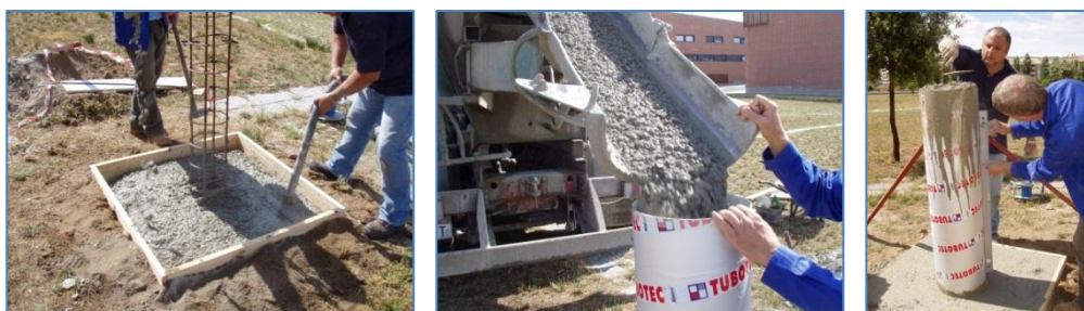
Figura 11.- Hormigonado de pilares
