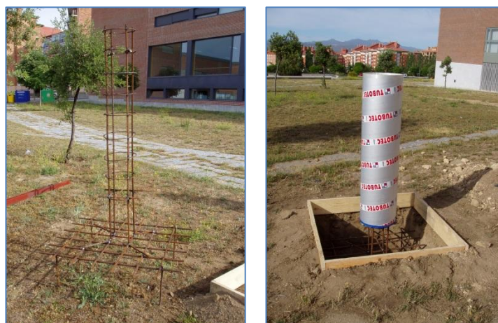
Figura 10.- Armado y encofrado de pilares.
