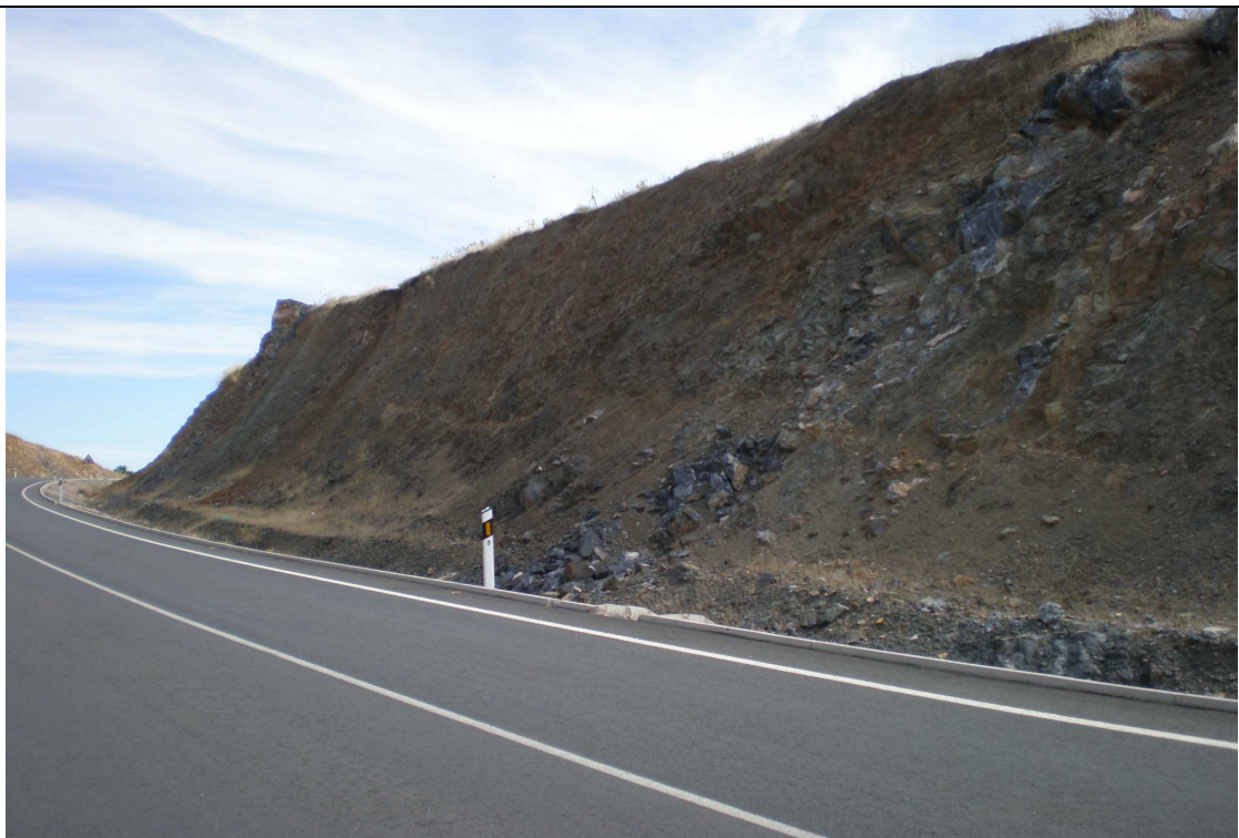
Fotografía 12. Vista general de desmonte, talud derecho, cercano al desmonte proyectado P.K. 5+800 a P.K. 6+500 excavado en dirección perpendicular al mismo en la EX.-214. La Roca de la Sierra-La Nava de Santiago. Marzo 2.010.
