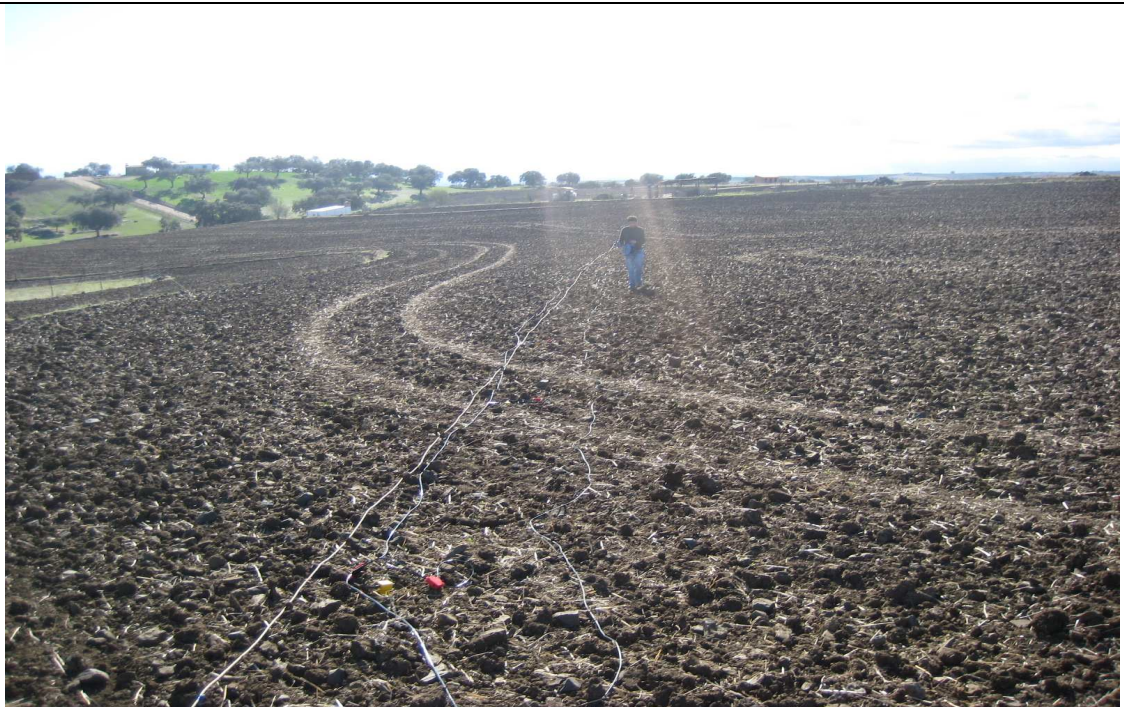
Fotografía 8. Vista general de desmonte P.K. 5+800 a P.K. 6+500 con dispositivo adoptado para realización de línea sísmica. Noviembre de 2.009.
