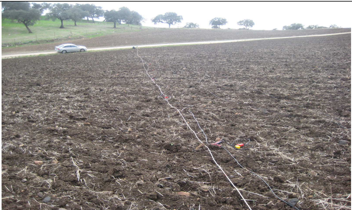
Fotografía 10. Vista general de desmonte P.K. 5+800 a P.K. 6+500 con dispositivo adoptado para realización de línea sísmica. Noviembre de 2.009.
