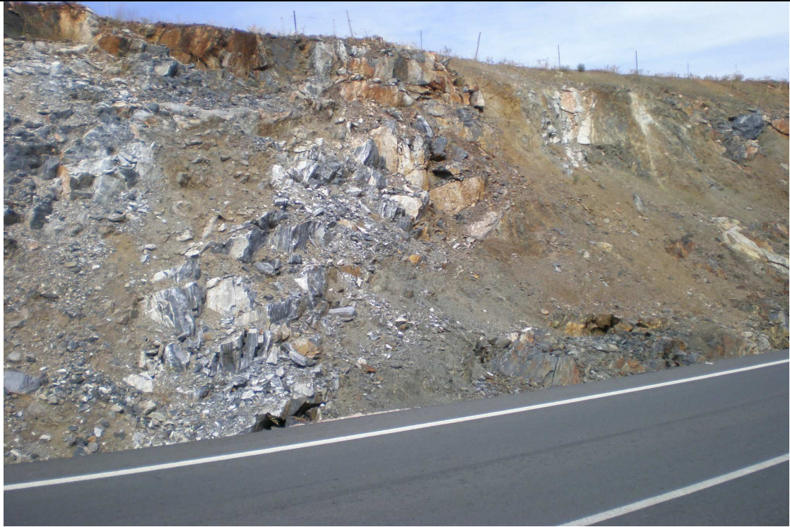
Fotografía 13. Vista particular de estructura tipo Sill, en el talud izquierdo excavado en la EX.-214. La Roca de la Sierra-La Nava de Santiago. Marzo 2.010.
