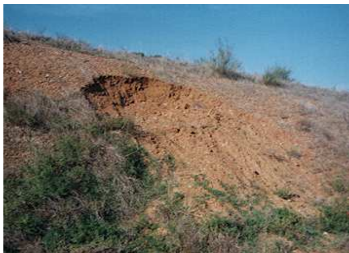
Imagen 17. Rotura de talud tipo circular en suelos homogéneos. Fuente: Elaboración propia. Año 2002.
