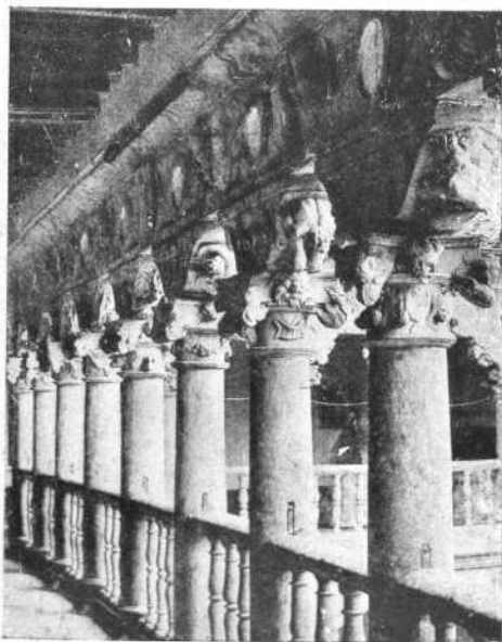
Zapatas en piedra del claustro de las Dueñas, de Salamanca.
