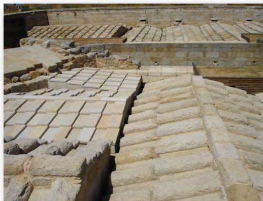
Figura 53: Techos de granito de las casamatas, a prueba de bombas de la época.
