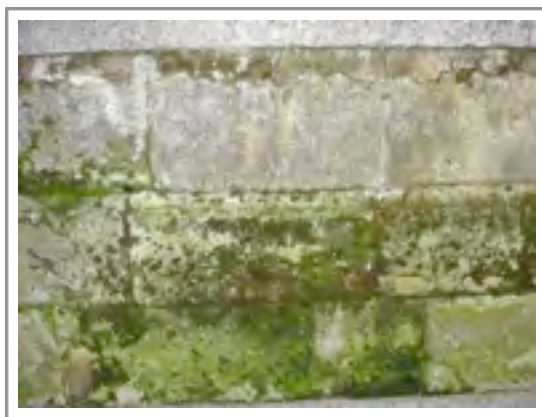
Figura 12: Colonización biológica en granito de Martinamor, Catedral Nueva.
