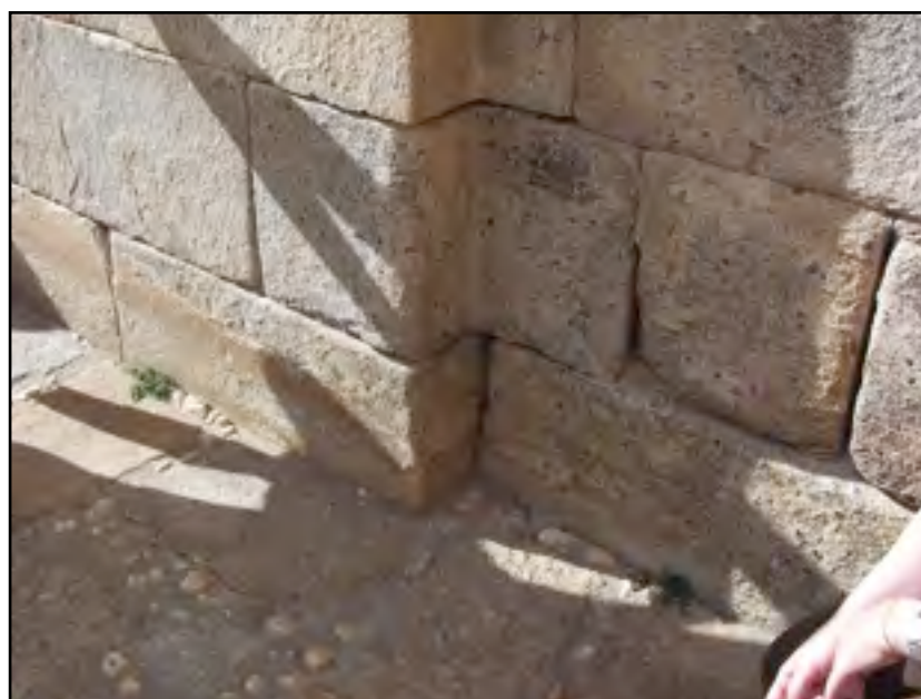
Figura 13: Piedra pajarilla o granito de Martinamor, se aprecian los nódulos de turmalina. La roca se ha visto afectada por la acción del agua, y por ciclos de hielo/deshielo.
