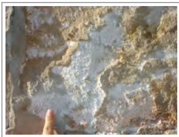
Figura 11: Precipitación de sales en la Casa Lis.
