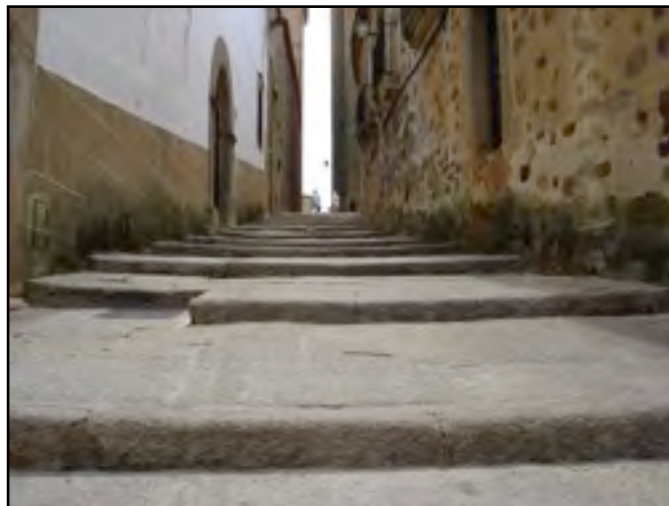
Figura 22: En esta calle de Cáceres se pueden observar mohos en ambos lados de la calle; el agua ha ascendido por capilaridad, ya que el granito que forma el enlosado de la calle peatonal es un material muy impermeable que no deja salir el agua subterránea que discurre por los bajos de la ciudad, ni filtrar el agua de lluvia que baje por la calle (Pereira y Cooper, en revisión).
