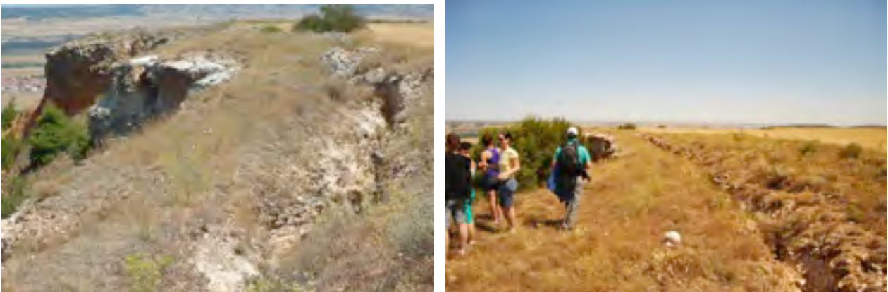
Figura 30: Grieta de tracción en el borde del páramo en Hontoria.
