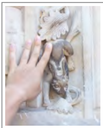
Figura 18: Liebre situada en la Puerta de Ramos (Catedral Nueva), sobre el cuál la gente pasa la mano, ya que se ha extendido el rumor de que es un elemento de buena suerte, así lo denominan “conejo de la suerte”. Aquí se observa un claro desgaste con adherencia de suciedad, ejemplo de deterioro antrópico.
