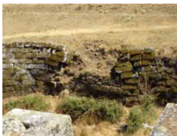
Figura 57: Degradación de los muros de contención de la fortaleza.
