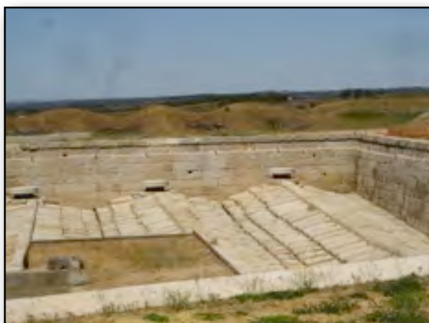
Figura 54: Casamatas, situadas bajo el nivel del suelo, que se observa en la parte más alta del muro.
