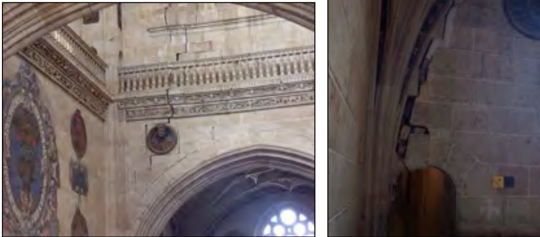
Figura 14: Efectos del terremoto de Lisboa en el interior de la Catedral Nueva.
