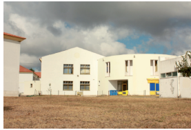
Figura IV. Vista do alçado posterior do Bloco B (centro) e em primeiro plano alçados laterais do Bloco C e do Pavilhão Gimnodesportivo. (Foto: Ana Bóia Cação)
