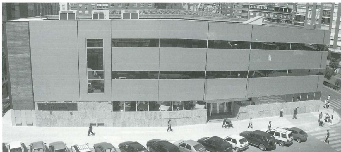
Fachada exterior de la Biblioteca de Talavera
