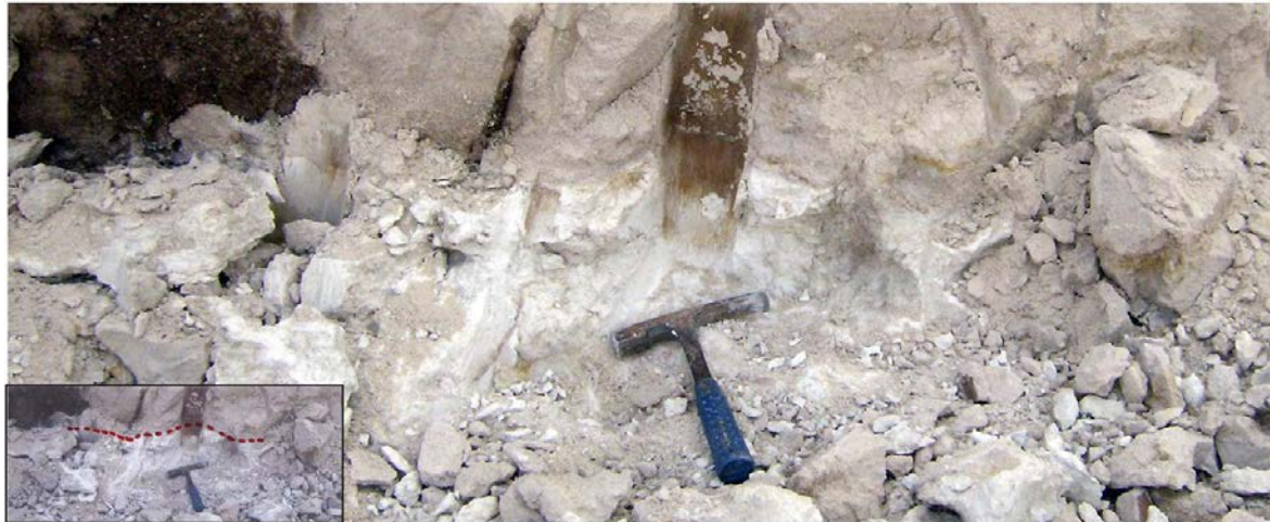
Figura.3.41 Contacto entre los materiales terciarios y el granito caolinitizado a una profundidad de más de 4 metros, en el frente 2 de Roderica N.
