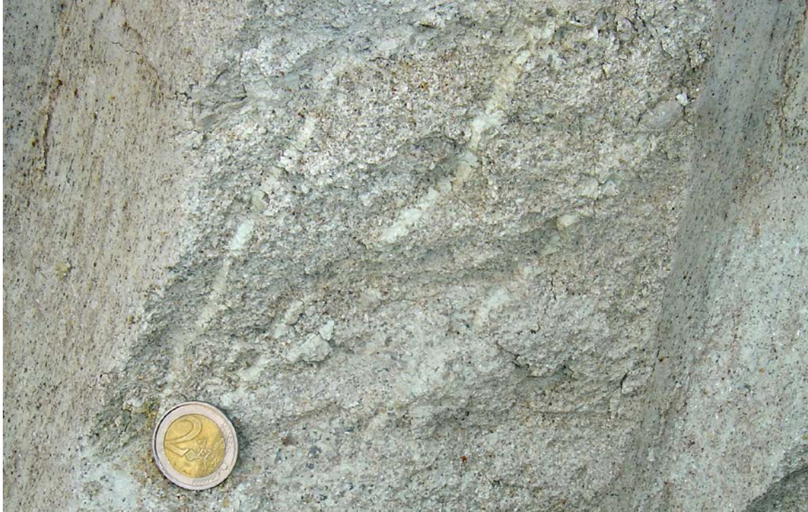
Figura.3.10 Foto de detalle de granito alterado (ZAHO) con pequeñas fisuras rellenas de material arcilloso blanquecino.
