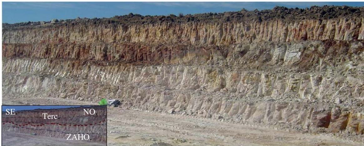
Figura.3.16 Aspecto de los frentes 3 y 4 de Navalacruz cuando la explotación ha avanzado unos metros.
