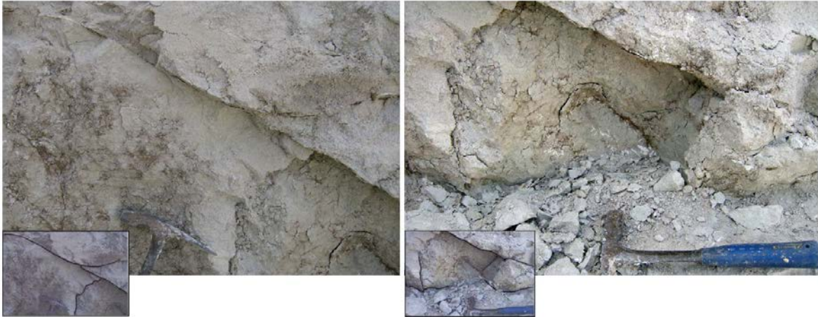
Figura.3.44 Fracturas en el Terciario en el frente 3 de la cantera de Roderica N. En la imagen de la derecha además se puede apreciar como asociado a las fracturas hay una capa de esmectitas muy puras.
