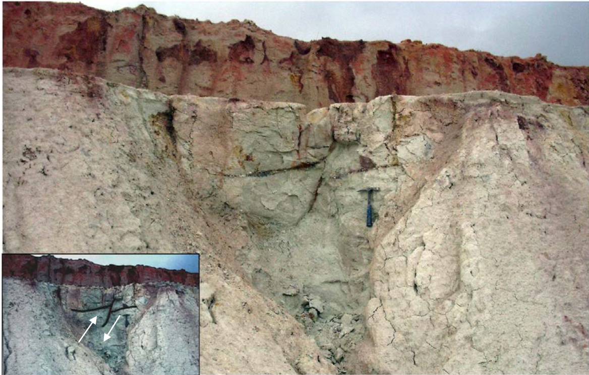
Figura.3.25 Detalle de una pequeña fractura con desplazamiento dentro del granito alterado, en el frente 1 de la cantera de Roderica.
