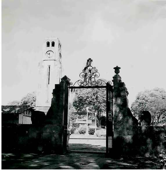
Fig. 4.16. Antiguo acceso al atrio de la parroquia, con pilastras de cantera que soportaban una reja de fierro colado y un copete forjado. Foto: Dr. Angel Zigler, cedida por Arturo Castelán Zacatenco.
