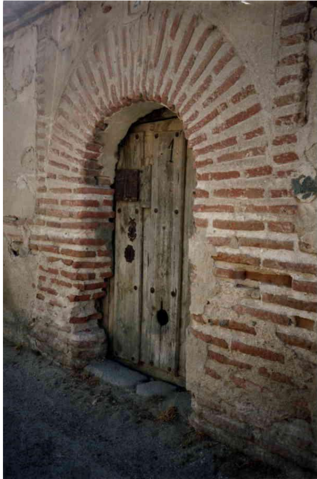
Panera del Pósito (Mamblas) (Fotografía: cortesía de Carmen Hidalgo Martín)
