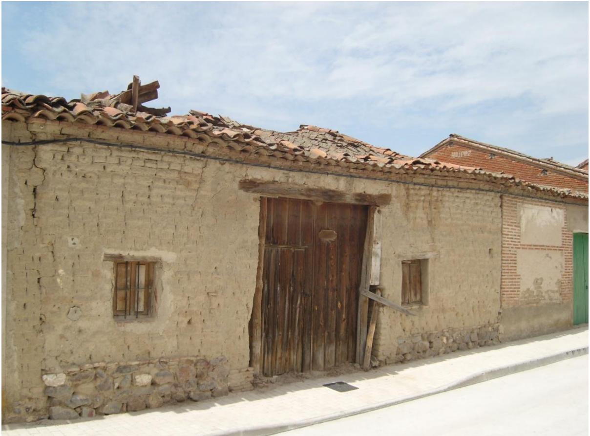
Construcción de adobe (Pajares de Adaja, 2010) (Fotografía: Luis Miguel Gómez Garrido)
