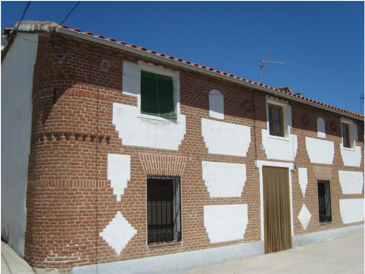
Típica casa mora de ladrillo y cal (Bercial de Zapardiel, 2010) (Fotografía: Luis Miguel Gómez Garrido)
