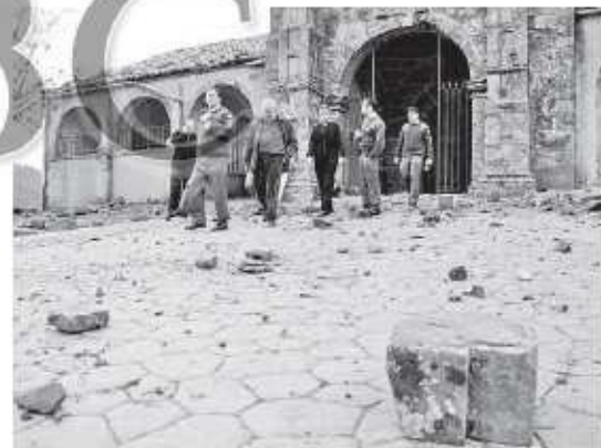
Fig. 141 Noticia aparecida en el diario ABC referente a los daños producidos por un rayo en Prioro (León)
