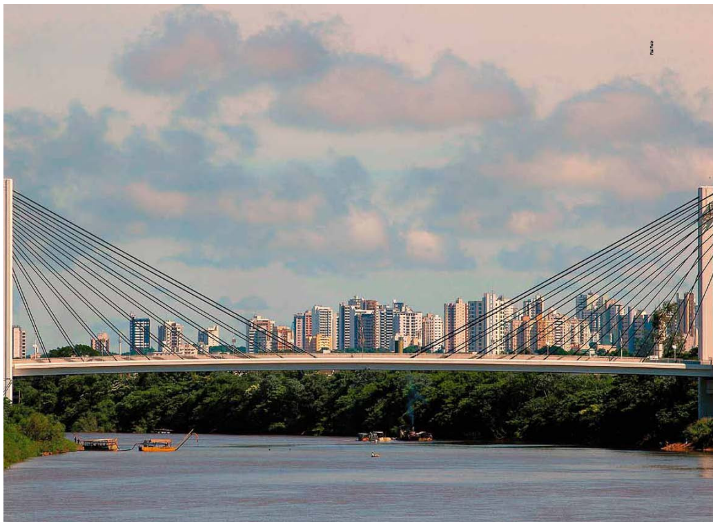
Figura 6: Ponte Sérgio Motta, com arranha-céus ao fundo. Fonte: Cuiabá, 2009, p.10.
