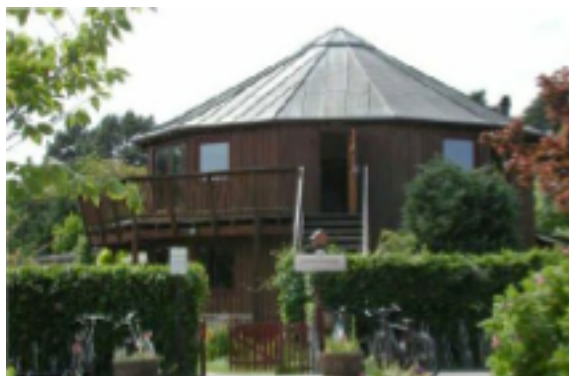
Centro Comunitario construido con madera de barriles de whisky reciclado.
