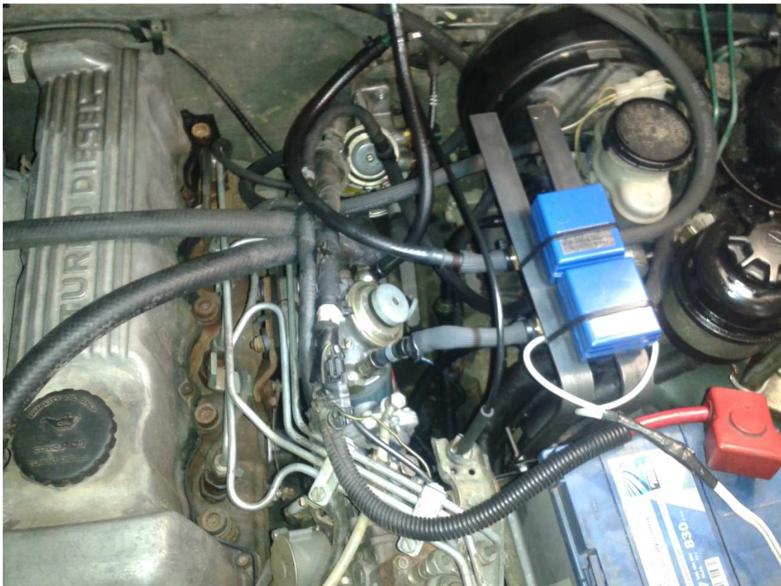
Detalle colocación electroválvulas y conjunto intercambiador-filtro
