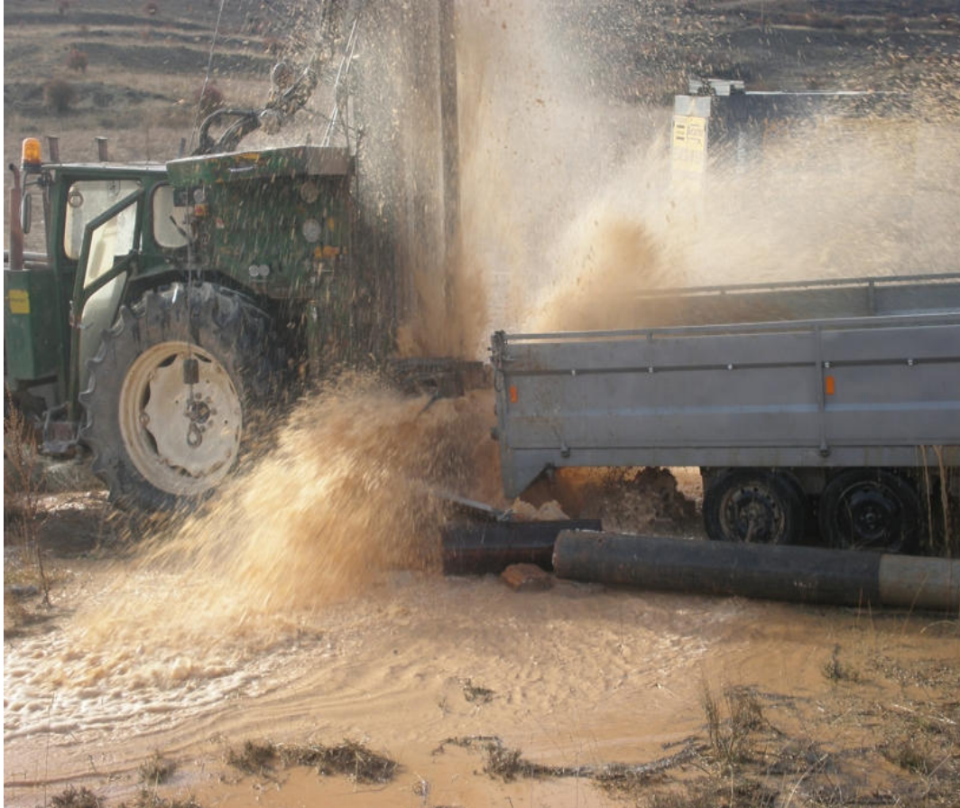
Imagen 20. Fotografía que capta el momento en que se alcanza la falla (a 48m de profundidad) y se recupera la fuente de los Aguachines.
