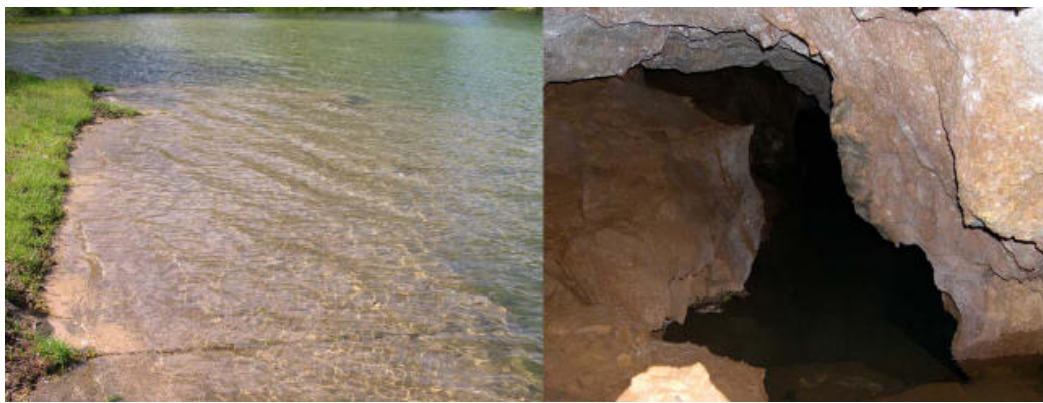
Imagen 37. Losa impermeabilizante (izda) y cavidad objeto de hormigonado (dcha) en la margen derecha
