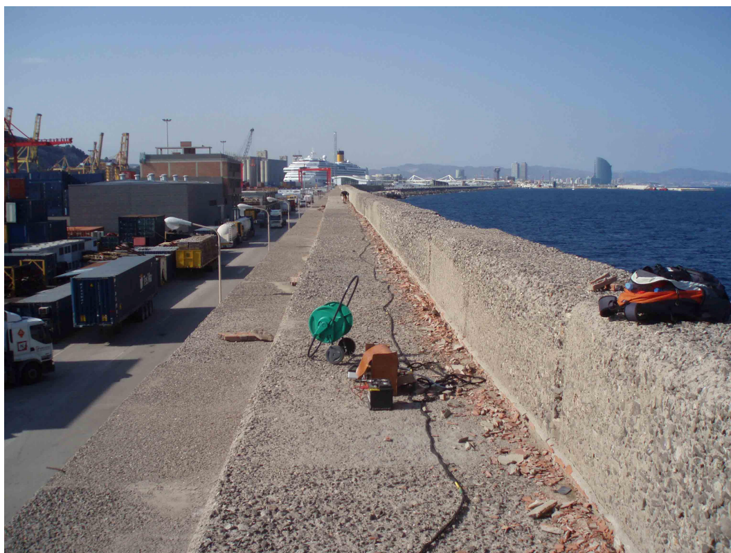
Imagen 57. Vista general de la zona de estudio en el Puerto de Barcelona con dispositivo adoptado para realización de Tomografía Eléctrica. Agosto de 2.009.
