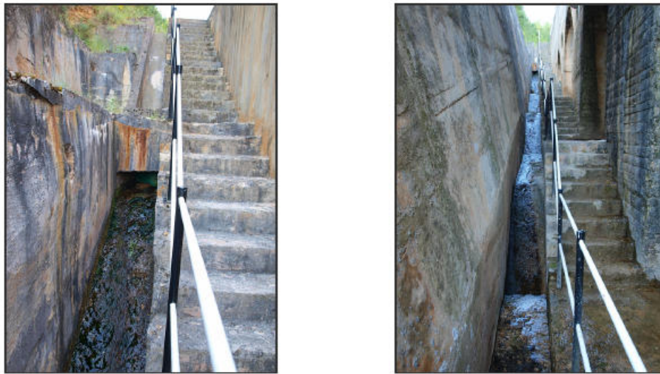
Imagen 35. Encauzamiento de filtraciones.
