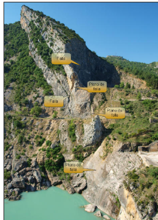
Imagen 28. Planos de falla aguas abajo del aliviadero, en a margen derecha de la presa
