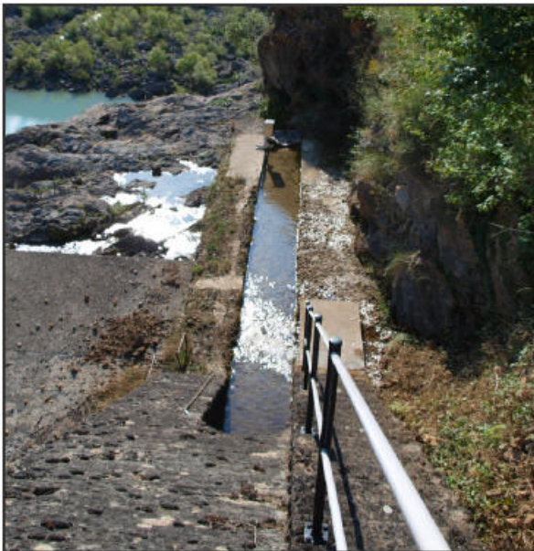
Imagen 36. Salida final de filtraciones y aforo.
