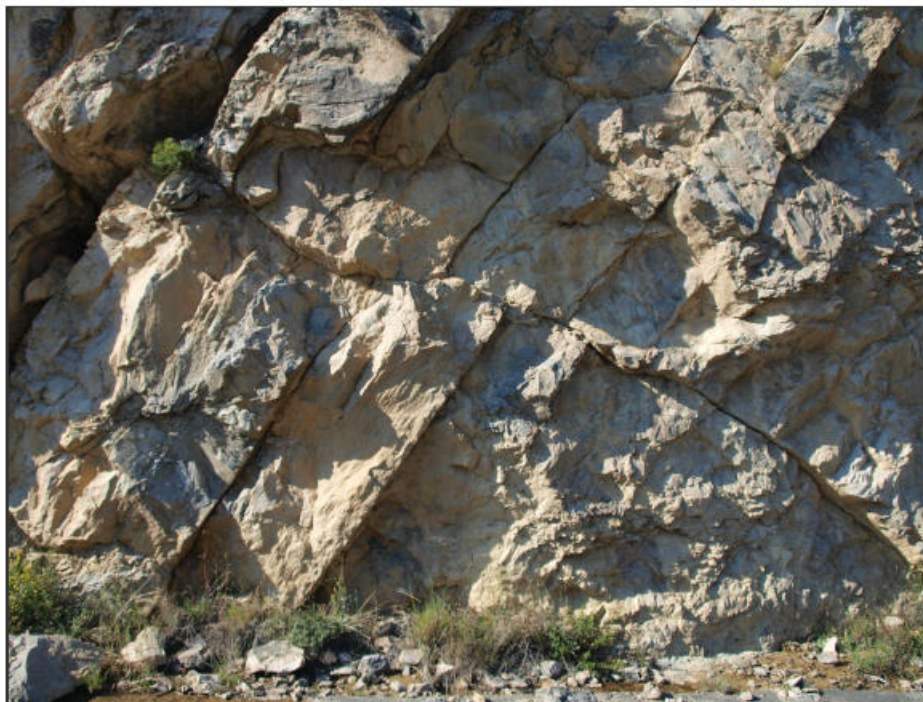
Imagen 29. Fractura de desplazamiento mínimo aguas abajo del estribo izquierdo de la presa
