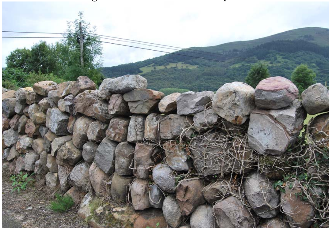
Figura 3.47. Detalle de muro de piedra
