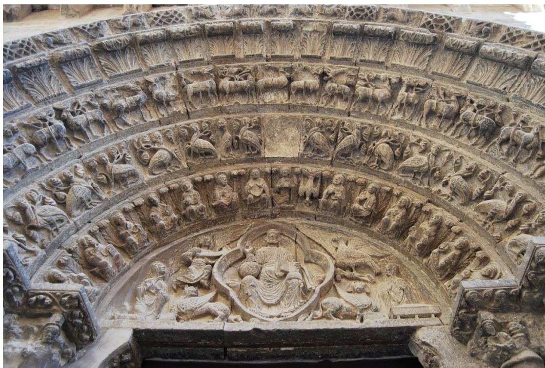
Detalle del tímpano y del conjunto de arquivoltas.
