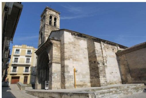
Vista lateral del acceso occidental. (Foto: B. Aldanondo)
