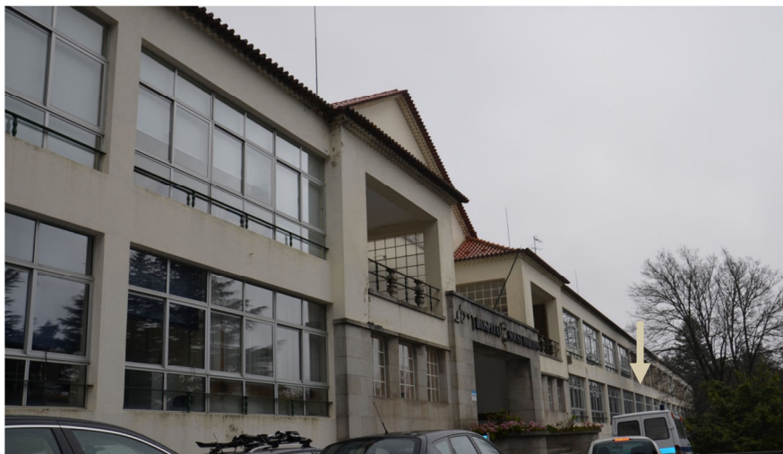
Fotografía 1: Fachada principal del hospital e frontal del servicio de pediatría
