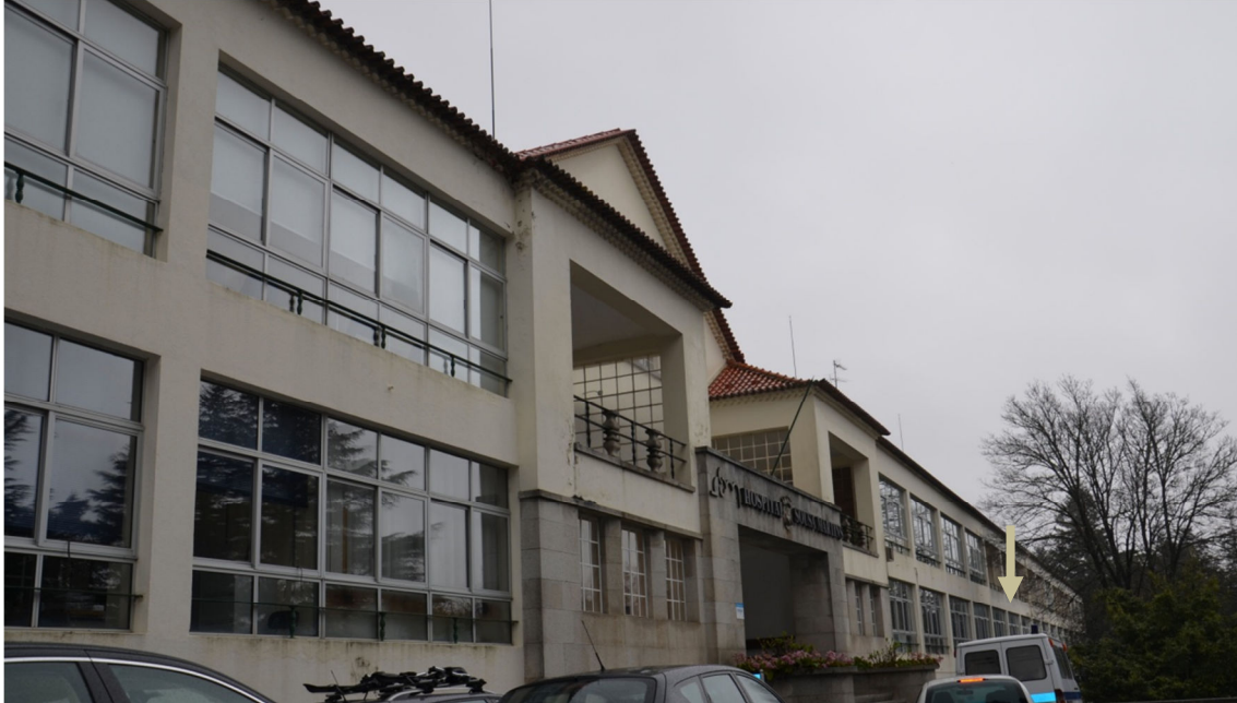
Fotografia 1: Fachada principal do hospital e frontal da unidade pediátrica
