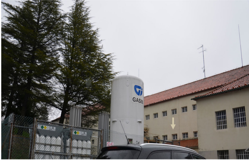
Fotografía 2: Fachada trasera del servicio de pediatría
