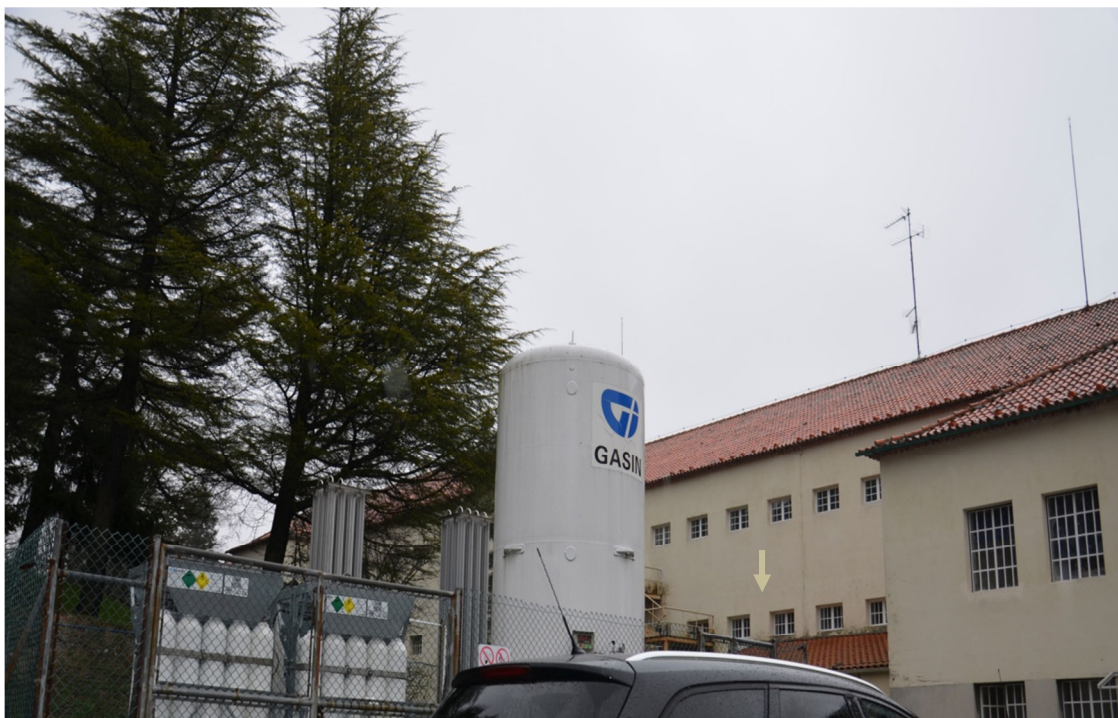
Fotografia 2. Fachada traseira da unidade pediátrica
