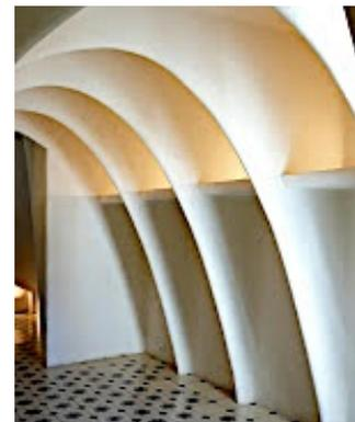
Fig. 73. Arcos catenarios en la buhardilla de la Casa Batlló. Fuente: GIRALT-MIRACLE, D. *La búsqueda de la forma...*, p. 34.
