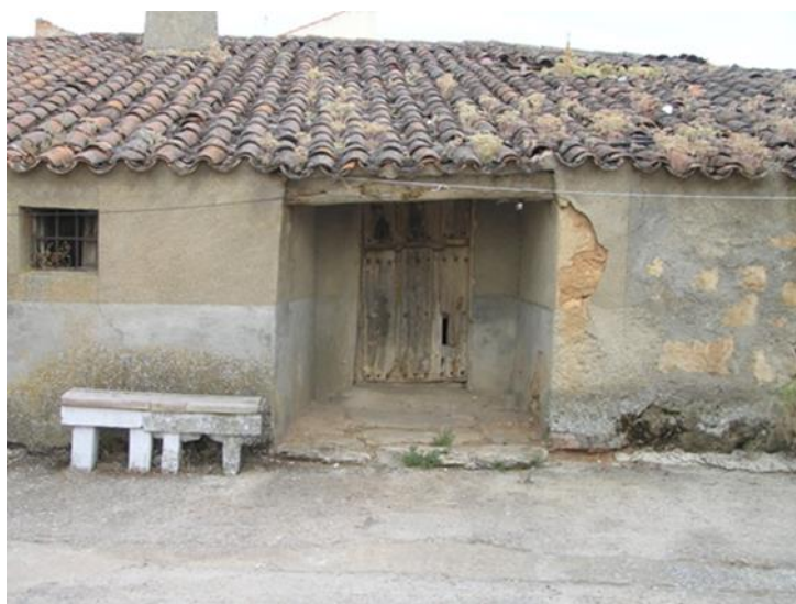
Fig. 4. Casa familiar de don Aníbal Sánchez Fraile Robliza de Cojos, Salamanca (julio de 2013)
