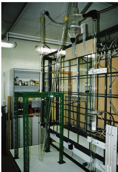
Figura 4.17. Imagen general de la instalación de filtración.
