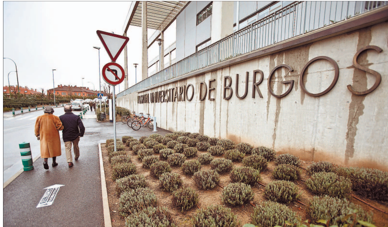
La marquesina quedará colocada junto a las grandes letras metálicas que rotulan la entrada. / LUIS LÓPEZ ARAICO
