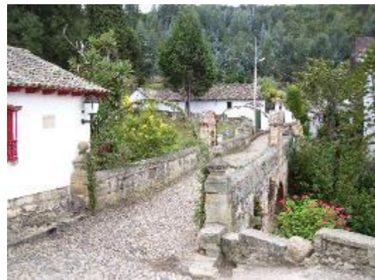
Fotografía 11. Monguí-Puente real de calicanto. Fuente: Campo Elías Bernal
