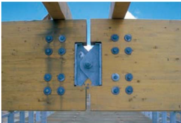
Unión articulada en la clave de un arco
