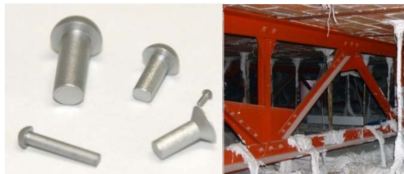
Figura 3-59. Roblones y estructura metálica con clavijas roblonadas.
