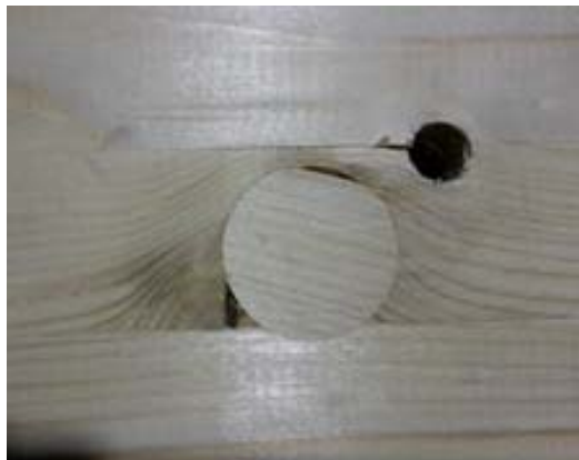
Figura 3-14. Reparación de defecto estructural por nudos en madera laminada estructural.
