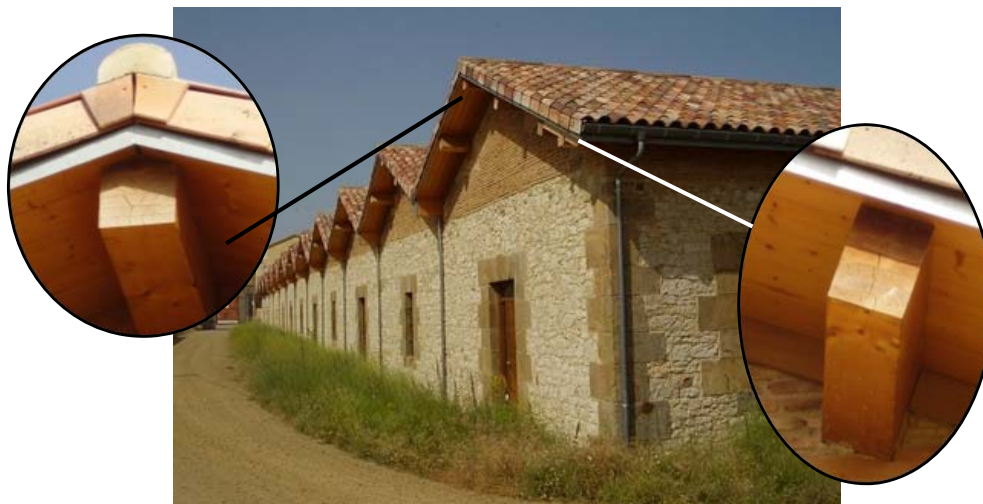
Figura 3-79. Edificación tras la rehabilitación de 2008 y detalles de las correas de madera laminada.
