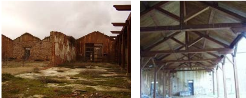
Figura 3-70. Vista de las naves antes y después de los trabajos de rehabilitación de 2003. Composición de cerchas.
