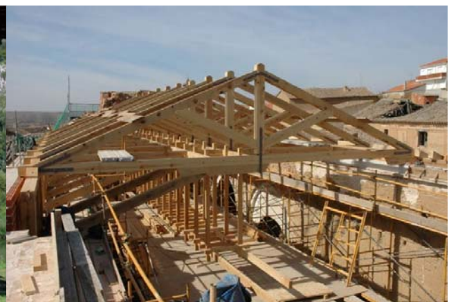
Cerchas de cubierta en la iglesia de Belver de los Montes, Zamora
