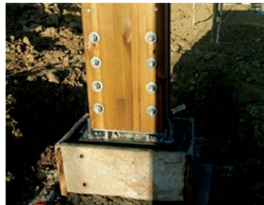
Nudo de un pilar de madera con la base de cimentación
