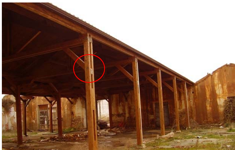
Figura 3-77. Composición de columnas con cerchas.
