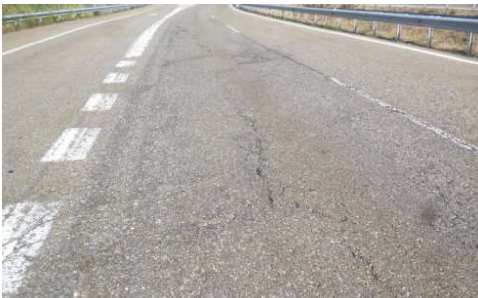
Fig. 3.37. Inspección visual (A-52 PK 107+500 CI).
