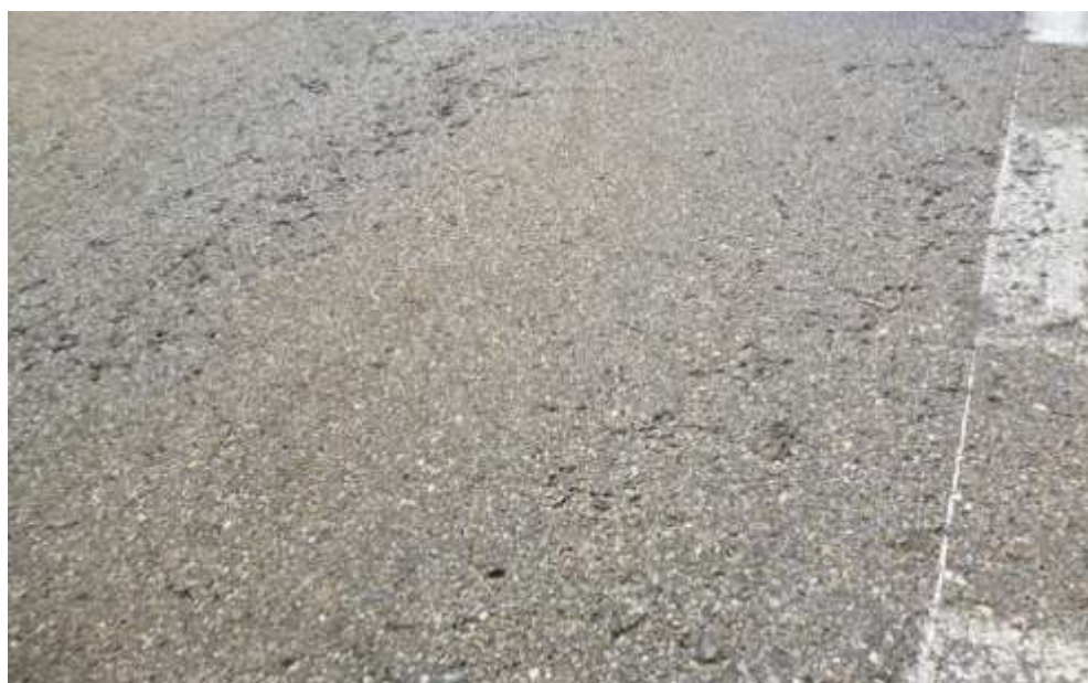
Fig. 3.33. Inspección visual (A-52 PK 106+200 CD).
