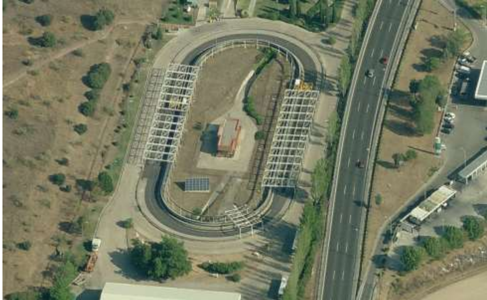
Fig. 2.20. Pista de ensayos del CEDEX.
