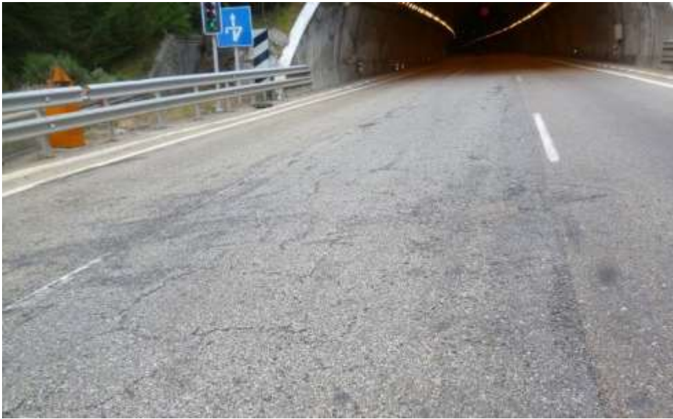
Fig. 3.31. Inspección visual (A-52 PK 97+800 CD).
