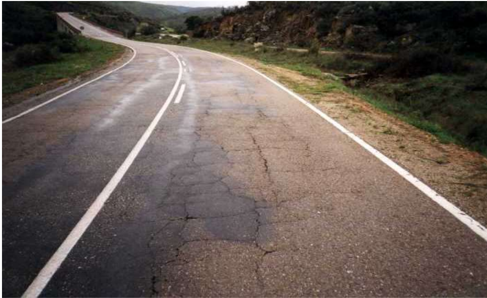
Fig. 2.21. Firme cuarteado en malla gruesa
