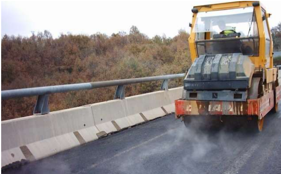
Fig. 3.5. Compactación de MBC.
