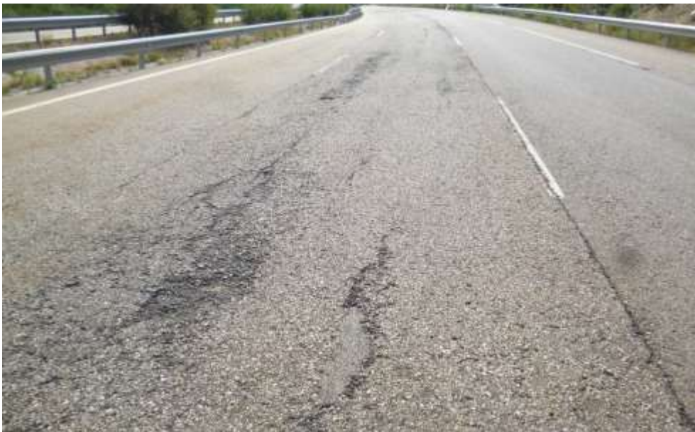
Fig. 3.35. Inspección visual (A-52 PK 110+600 CD).
