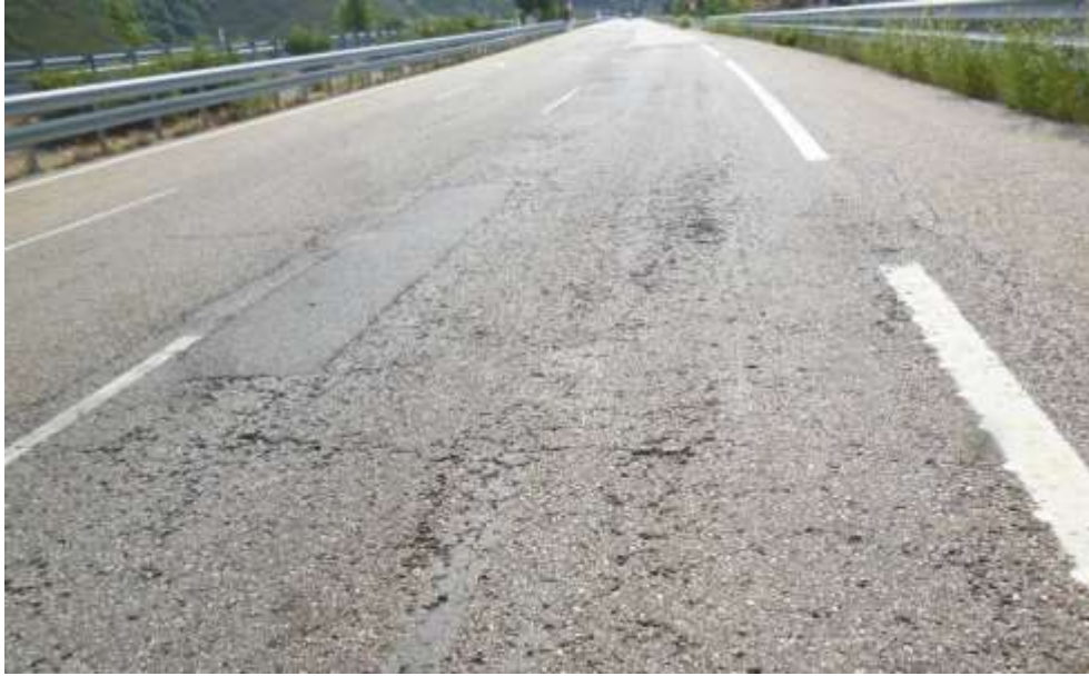
Fig. 3.34. Inspección visual (A-52 PK 110+800 CD).
