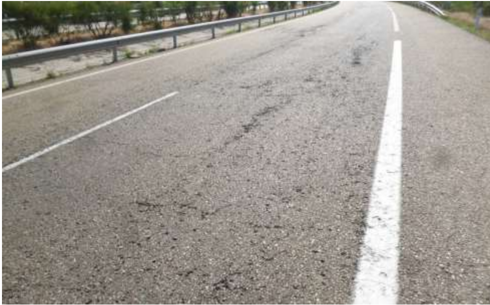
Fig. 3.38. Inspección visual (A-52 PK 109+500 CI).
