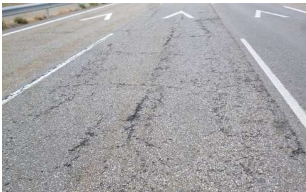
Fig. 3.29. Inspección visual (A-52 PK 95+800 CD).
