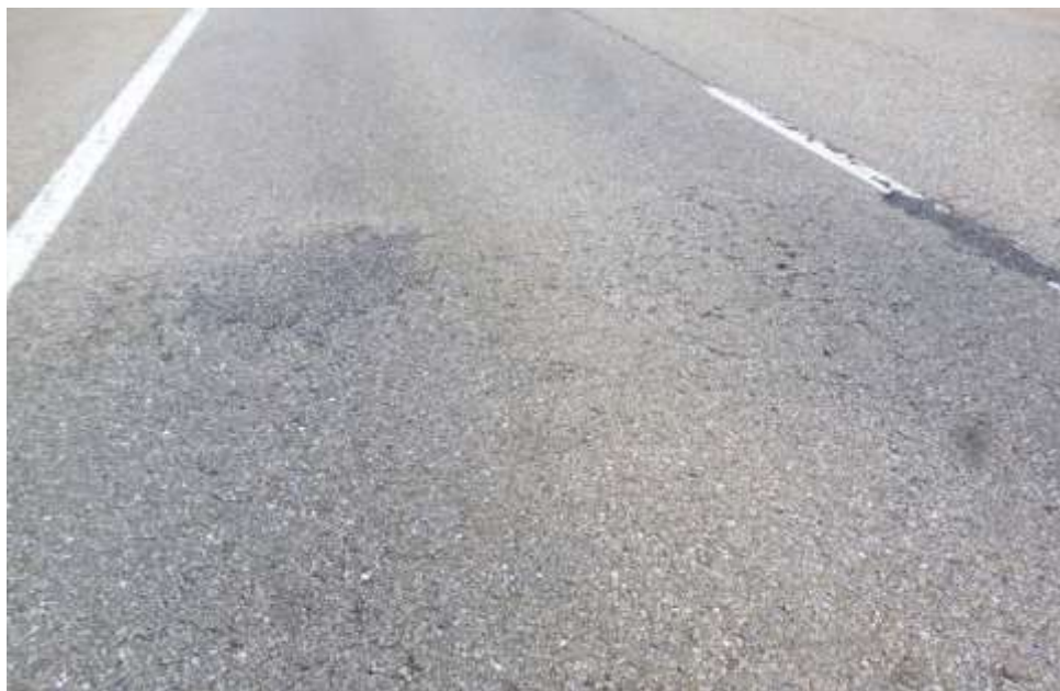
Fig. 3.28. Inspección visual (A-52 PK 94+130 CD).
