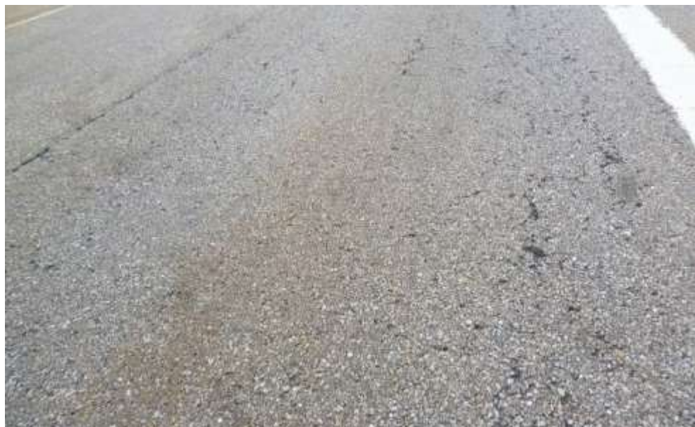
Fig. 3.32. Inspección visual (A-52 PK 104+900 CD).
