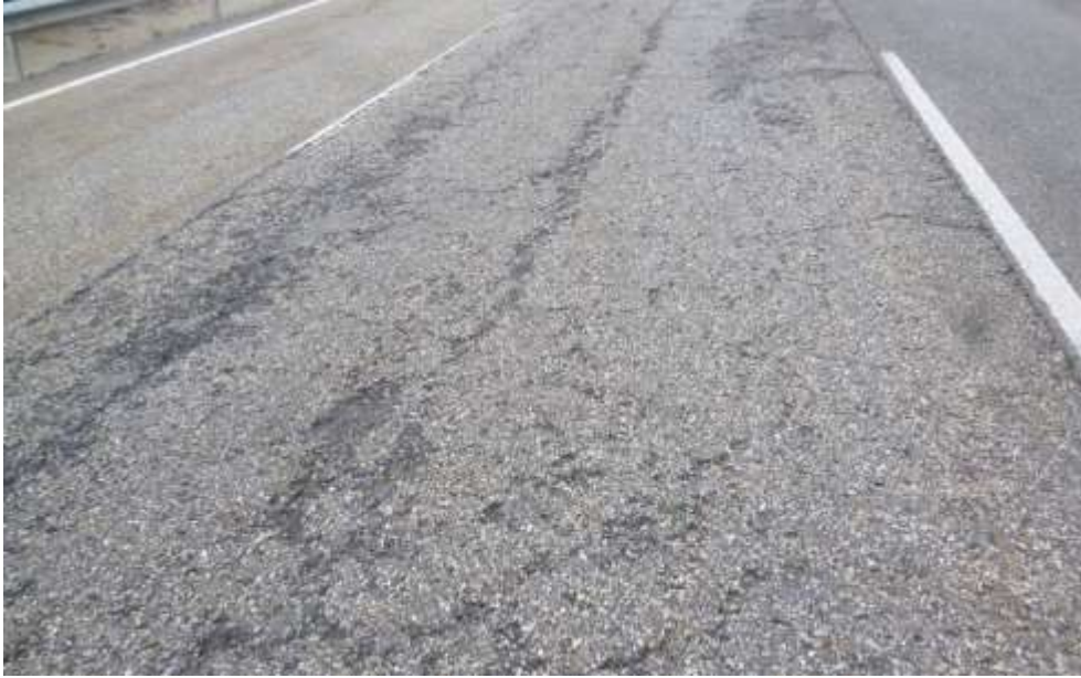
Fig. 3.30. Inspección visual (A-52 PK 96+800 CD).
