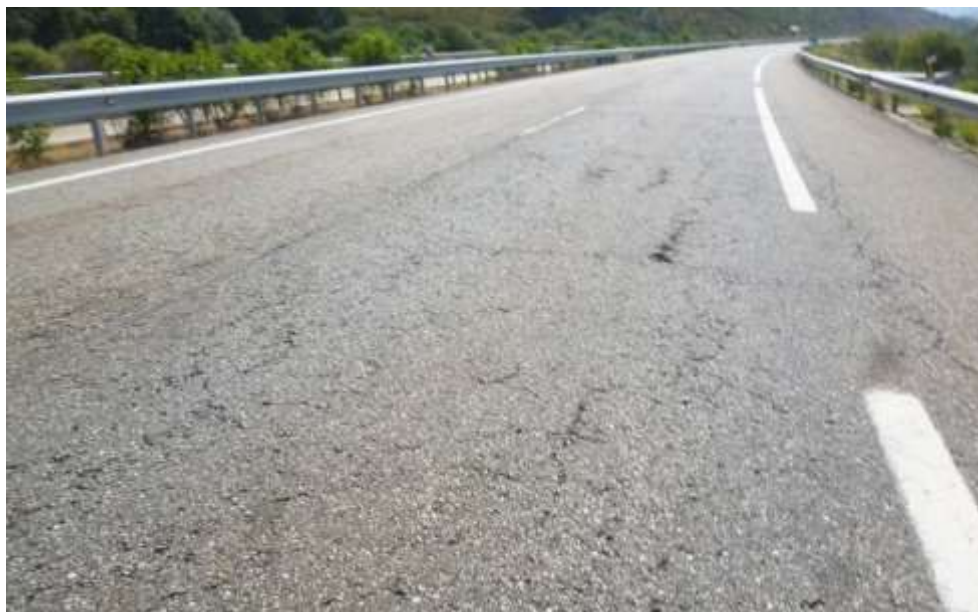
Fig. 3.36. Inspección visual (A-52 PK 94+800 CI).
