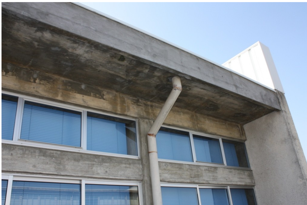
Figura 84. Escola Secundária Cristina Torres. Cobertura metálica num bloco de aulas. (Foto: Ana Cação)
