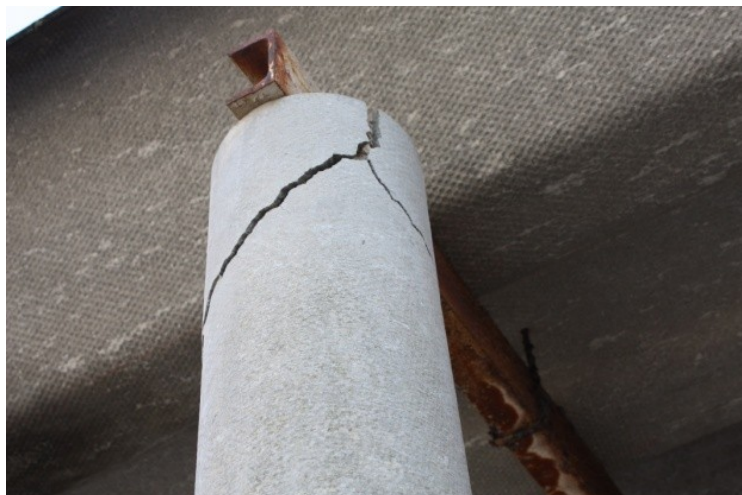
Figura 126. Escola Secundária Cristina Torres. (Foto: Ana Cação)
