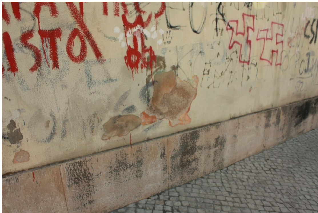
Figura 80. Escola Secundária José Falcão. Pormenor do alçado lateral. (Foto: Ana Cação)
