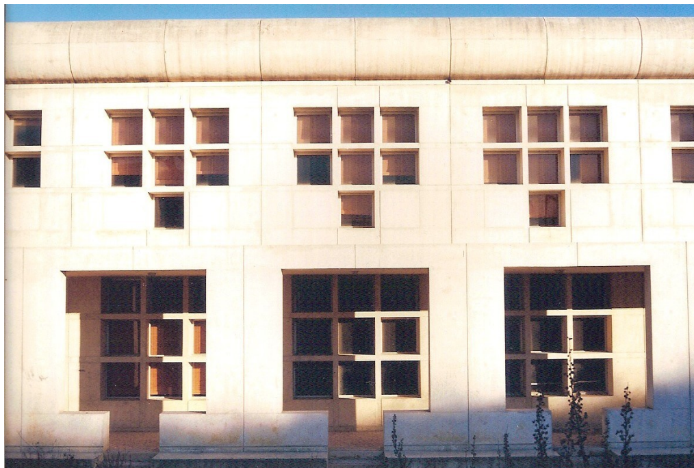
Figura 31. Escola Secundária de Benfica. Vista sobre as janelas de uma sala de aula. (Fonte: DSIF; Foto: Arq. RHF)
