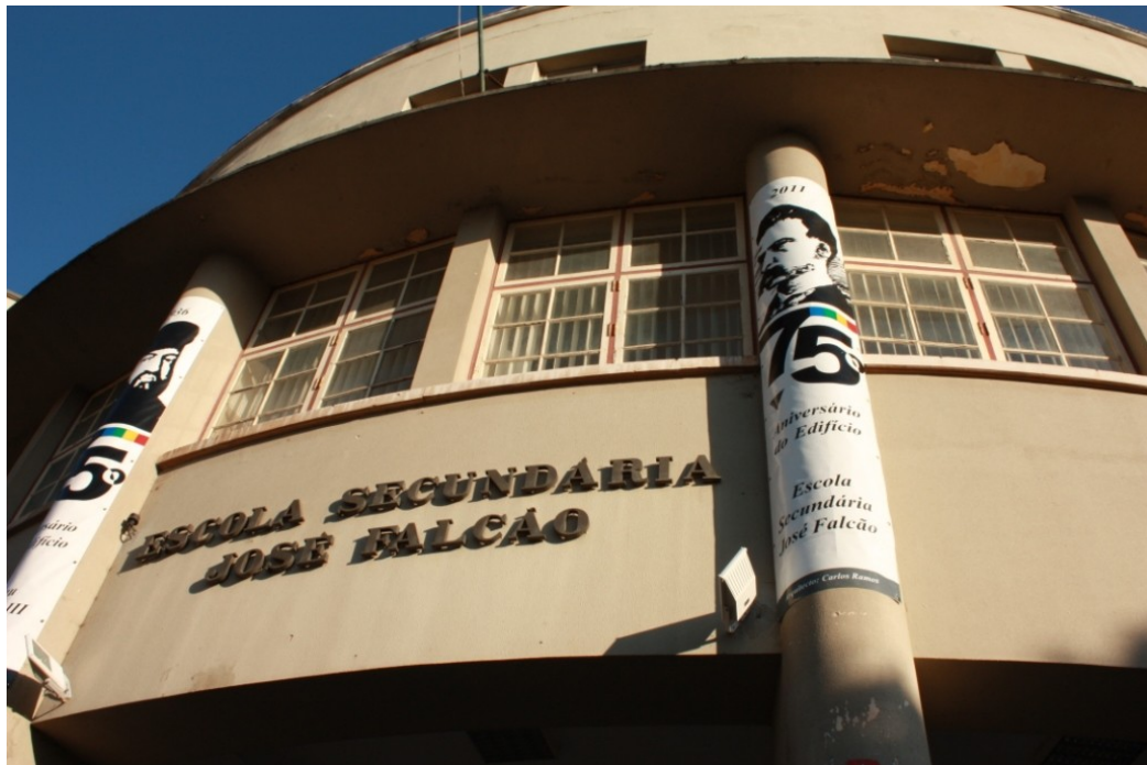
Figura 78. Escola Secundária José Falcão. Perspectiva da fachada principal. (Foto: Ana Cação)
