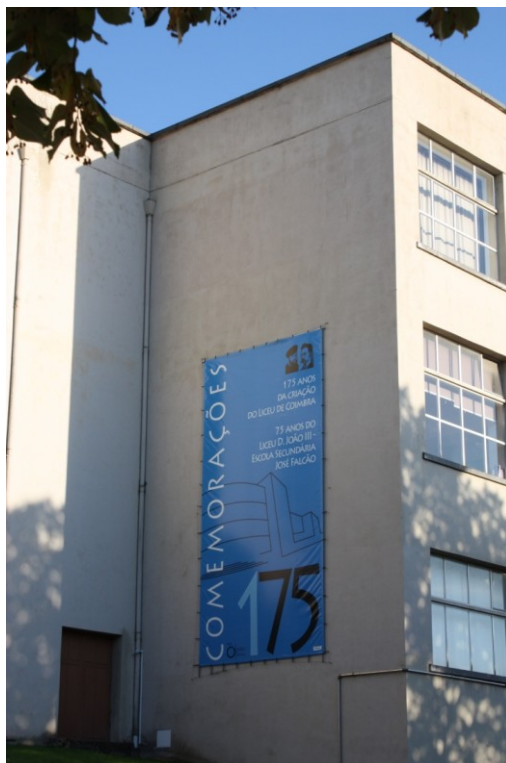
Figura 73. Escola Secundária José Falcão. Pormenor do alçado lateral. (Foto: Ana Cação)
