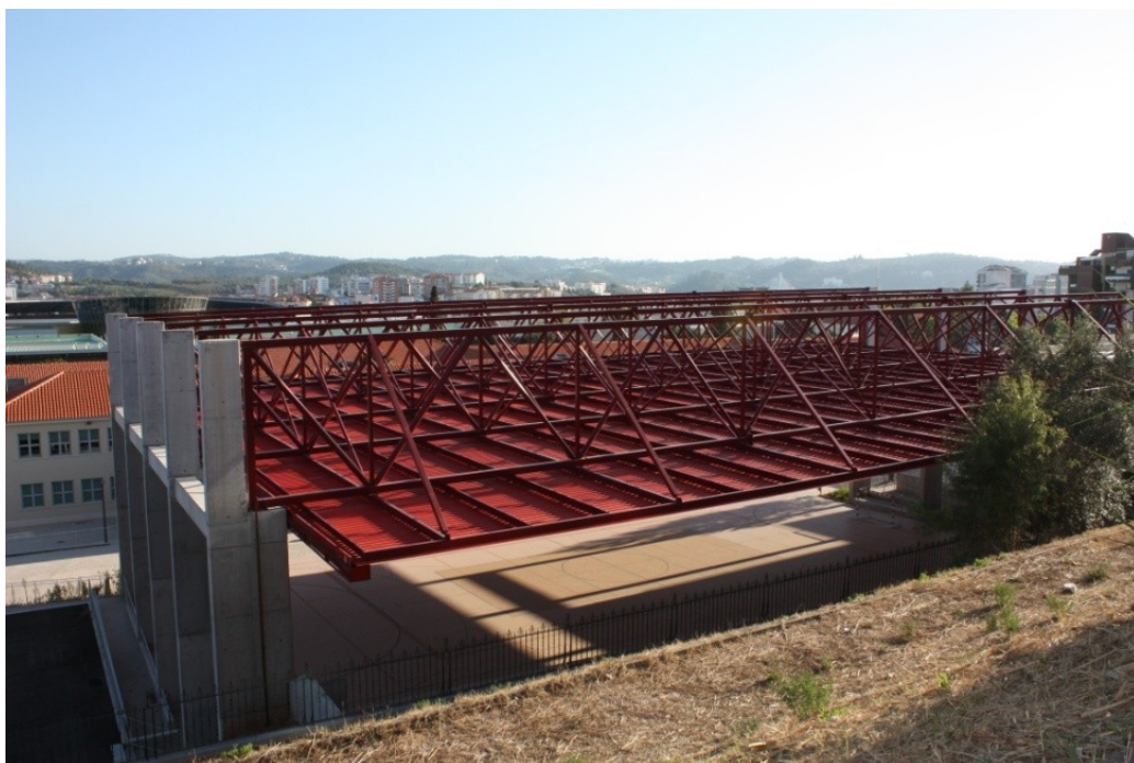
Figura 119. Escola Secundária Infanta D. Maria. Vista sobre o novo pavilhão Gimnodesportivo. (Foto: Ana Cação)
