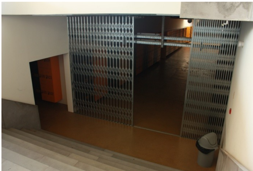
Figura 61. Escola Secundária Dr. Joaquim de Carvalho. Entrada que dá acesso à Biblioteca, ao Auditório e a outros locais. (Foto: Ana Cação)
