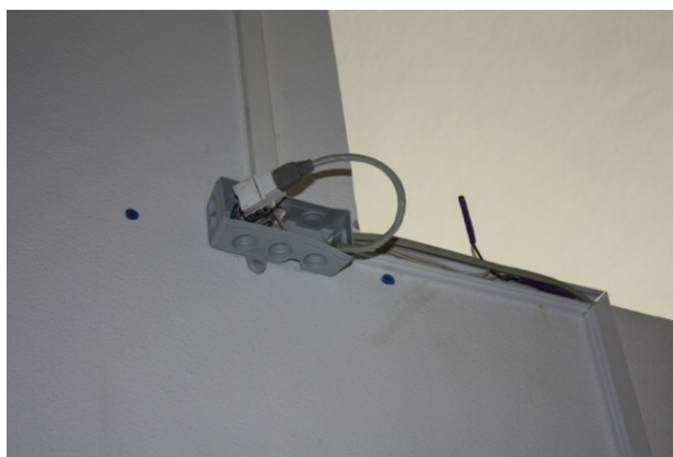
Figura 107. Escola Básica dos 2.º e 3.º Ciclos com Ensino Secundário da Guia. O «choque tecnológico» – Bloco A. (Foto: Ana Cação)
