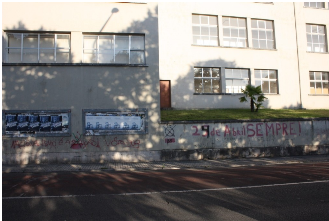
Figura 81. Escola Secundária José Falcão. Alçado lateral. (Foto: Ana Cação)
