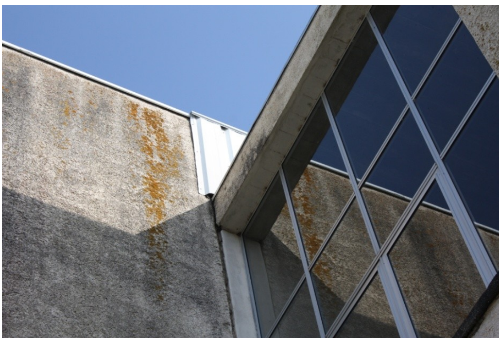
Figura 125. Escola Secundária Cristina Torres. (Foto: Ana Cação)
