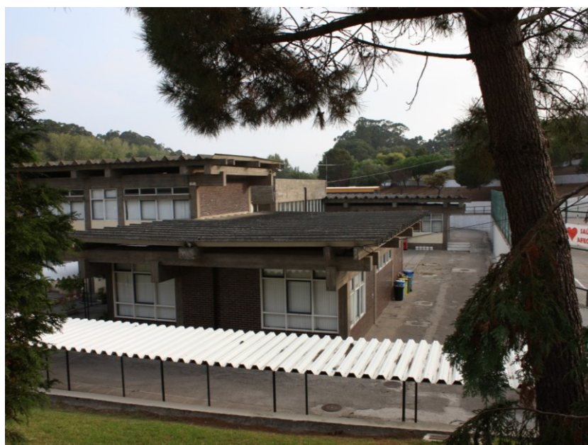
Figura 24. Escola Básica dos 2.º e 3.º Ciclos Dr. João de Barros. Vista sobre a cobertura e passadiços. (Foto: Ana Cação)
