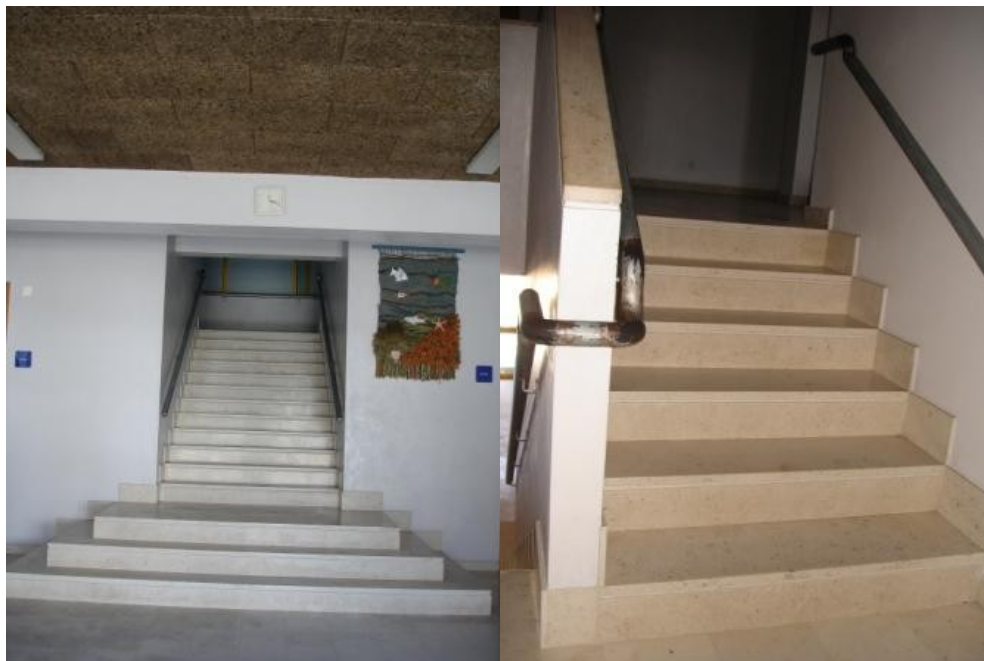
Figura 43. Primeiro e segundo lances de escadas de acesso ao 1.º andar do Bloco C. (Foto: Ana Cação)
