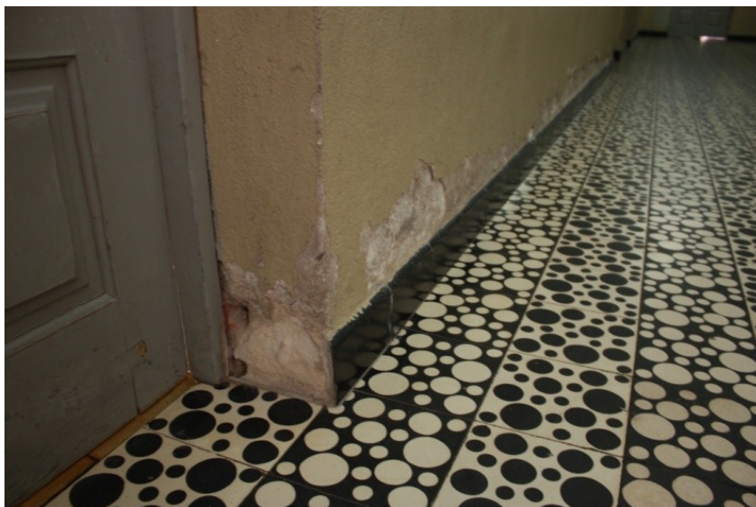
Figura 104. Escola Básica dos 2.º e 3.º Ciclos com Ensino Secundário da Guia. Porta de entrada de uma sala de aula do Bloco A. (Foto: Ana Cação)
