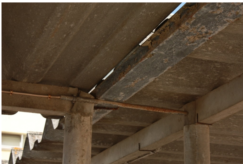
Figura 128. Escola Secundária Cristina Torres. (Foto: Ana Cação)
