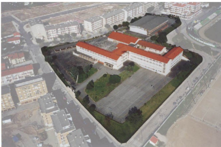
Figura 53. Vista panorâmica da Escola Secundária Dr. Joaquim de Carvalho (Fonte: Google earth )
