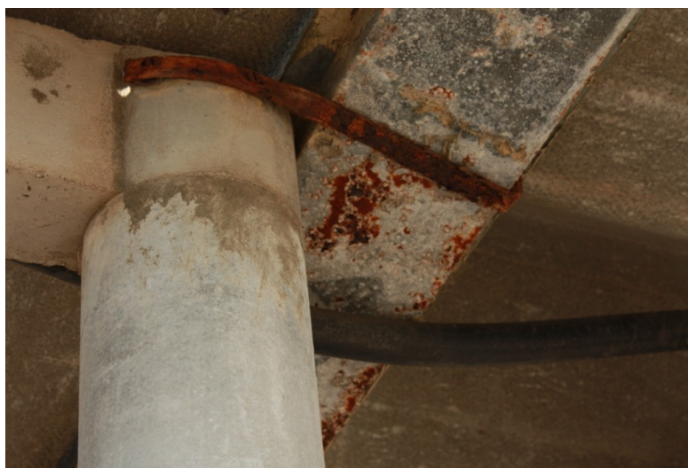
Figura 127. Escola Secundária Cristina Torres. (Foto: Ana Cação)
