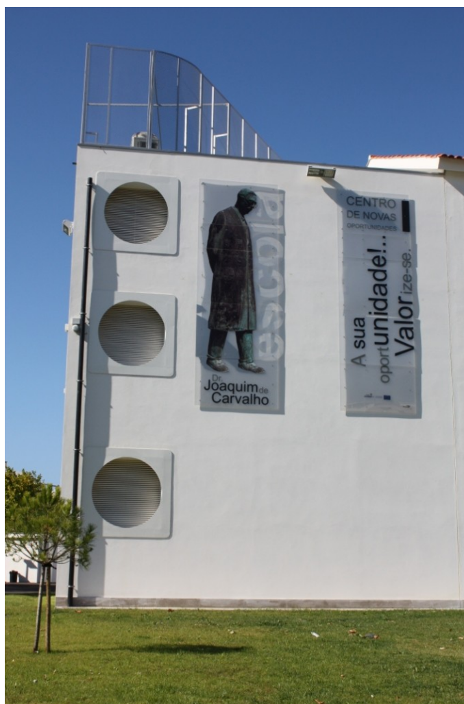
Figura 89. Escola Secundária Joaquim de Carvalho. Instalação do sistema AVAC na cobertura. (Foto: Ana Cação)
