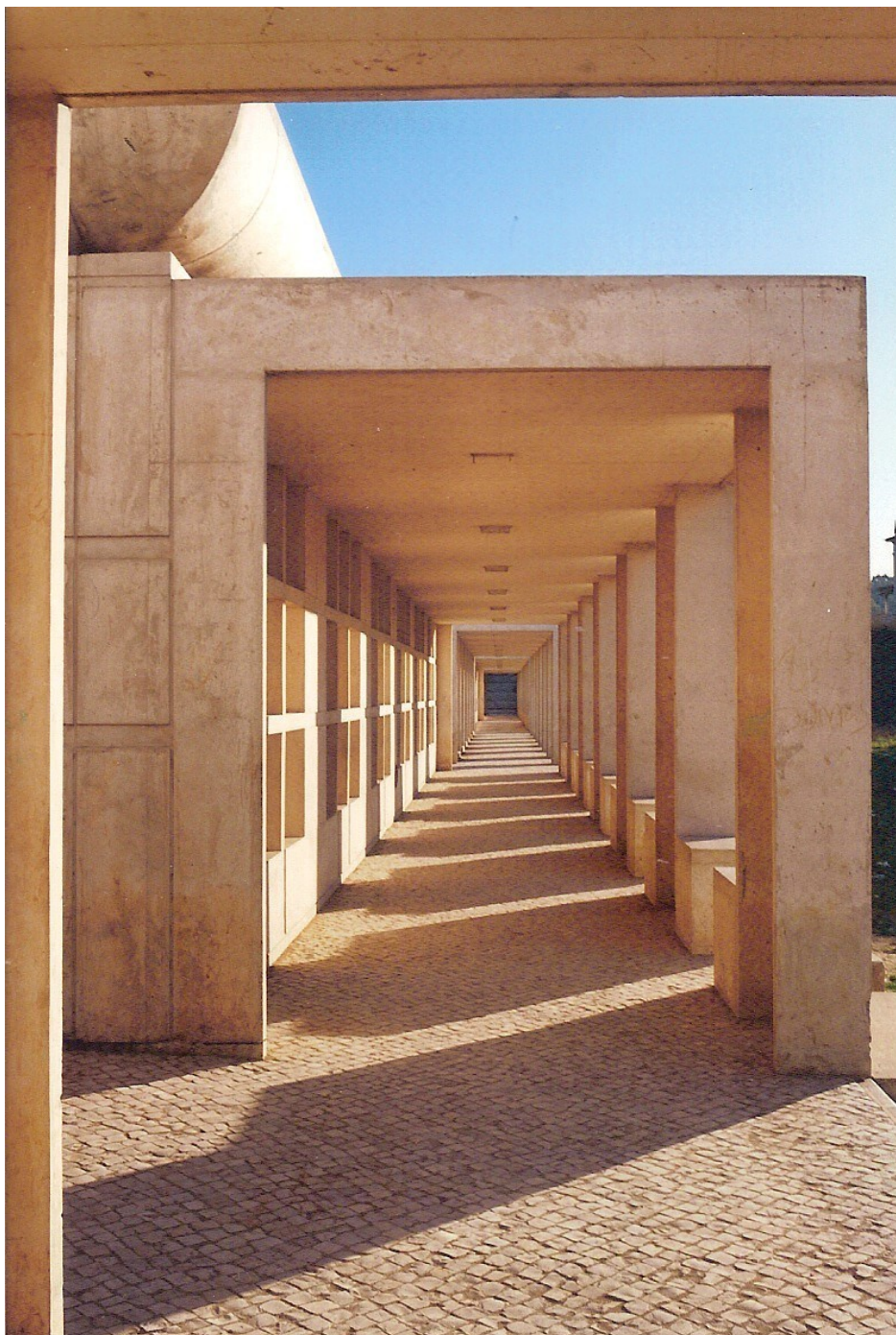
Figura 10. Perspectiva de um passadiço. Escola Secundária de Benfica. (Fonte: MOP/JCETS, Foto: Arq. RHF)
