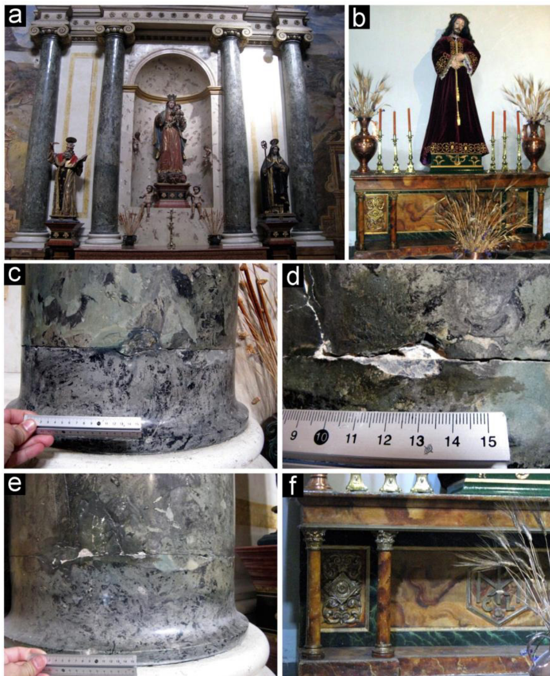
Figura 61. a) Columnas realizadas en serpentinita en una de las capillas laterales de la iglesia; b) altar realizado en “mármol” rojo con los bordes en serpentinita; c) junta horizontal observada en las cuatro columnas, en la que, además, en este caso se observa una clara diferencia de tonalidad; d) pérdida de material; e) pérdida de material y relleno con otro material tipo estuco o similar, pintado de verde; f) detalle del altar de la capilla anexa, en el que aparentemente no se observan daños.
