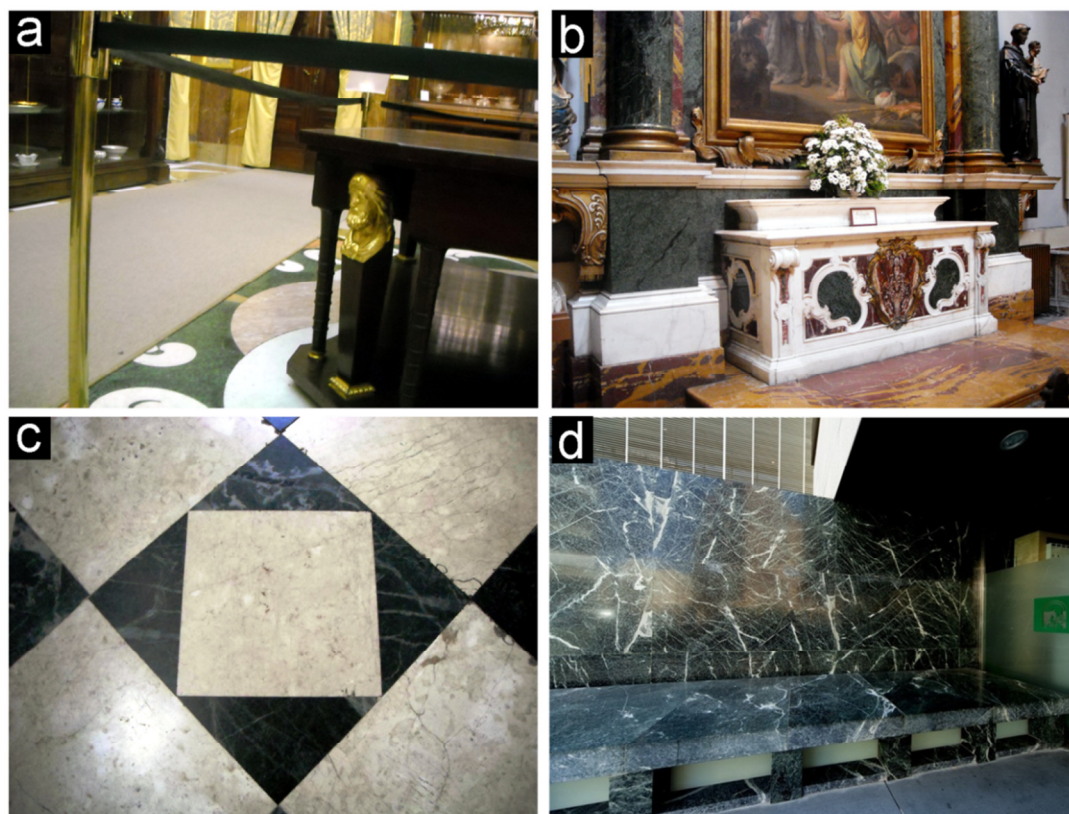
Figura 111. Ejemplos del uso principal de las serpentinitas del Complejo Nevado-Filábride: a) suelo del Palacio Real de Madrid ( Verde Granada ); b) aplacados y columnas en el convento de las Salesas Reales de Madrid ( Verde Granada ); c) suelo de la Catedral de Nuestra Señora de La Almudena de Madrid ( Verde Macael ); d) aplacados en la ciudad de Justicia de Almería ( Verde Macael ). Foto d cedida por Mármoles Naturales Macael, S.L.
