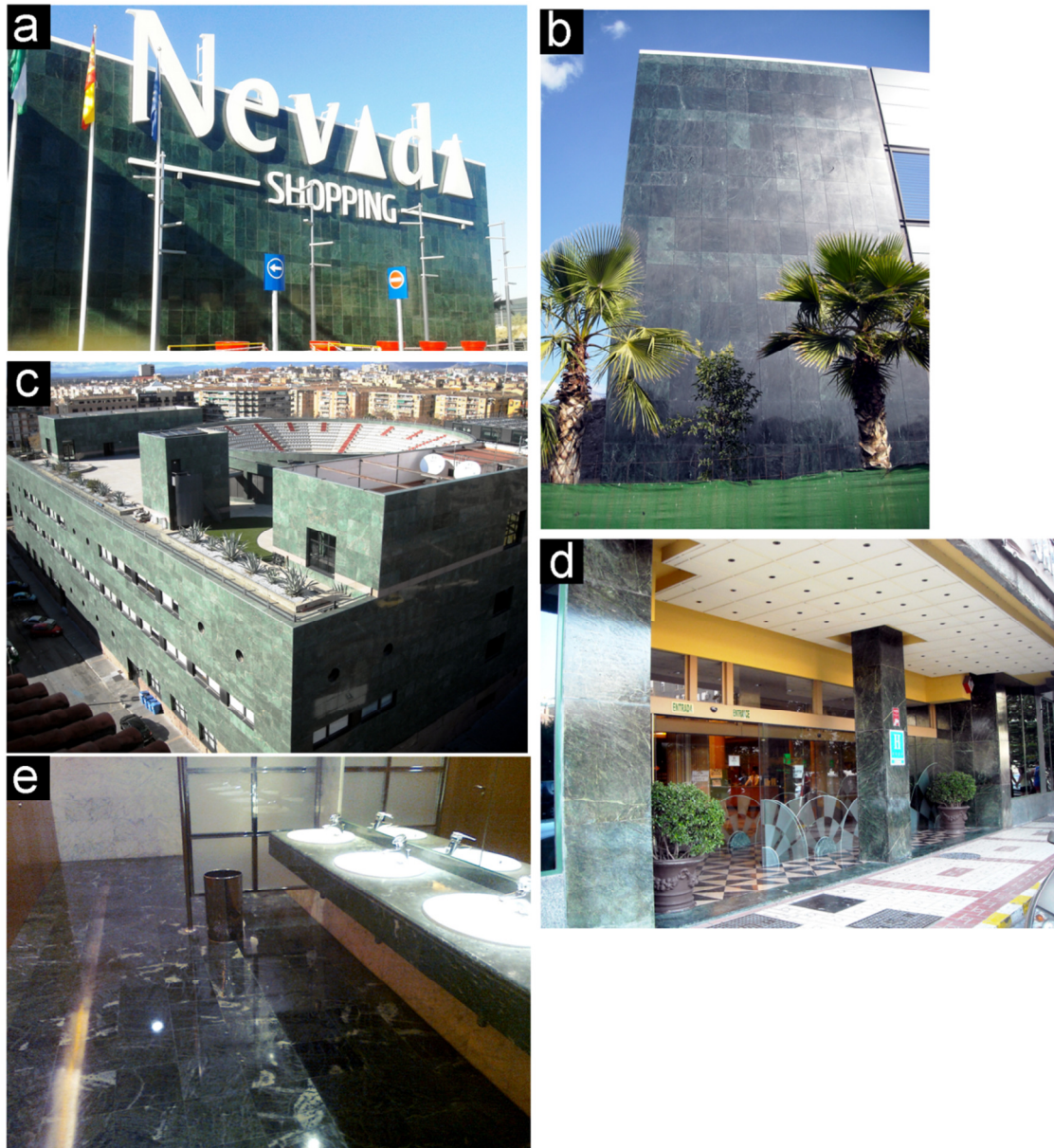
Figura 11. Algunos ejemplos de arquitectura actual en Granada en los que se ha empleado serpentinita en su construcción: a) vista de la fachada del Centro Comercial Nevada, actualmente en construcción; b) detalle de la fachada de este centro comercial; c) palacio de Exposiciones y Congresos; d) fachada y suelo del hotel San Antón; e) suelo y encimera de un baño del hotel San Antón.
