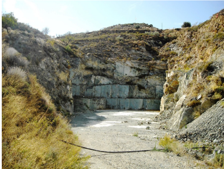
Figura 25. Vista general de la “C.E. Verde Almería” (t.m. Albanchez, Almería).
