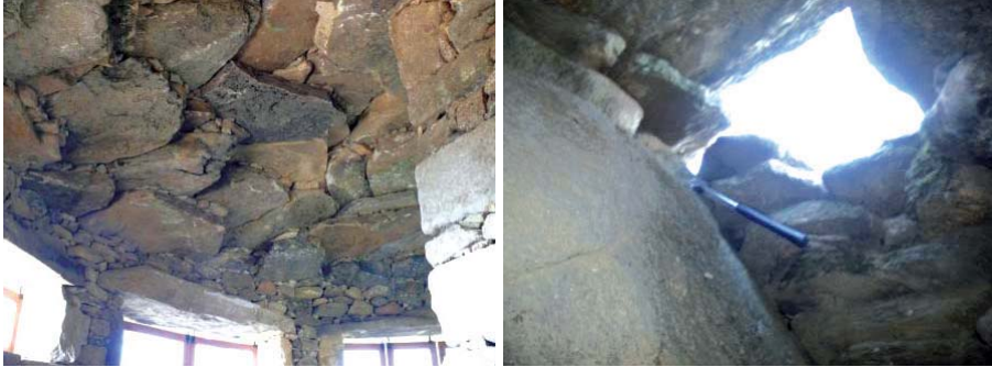
Figura 23A. Detalle del apilamiento de las piedras en las paredes y el techo de un observatorio ornitológico cercano, simulando la forma de construcción de los antiguos chozos como el aquí estudiado. B: Imagen de la abertura que hace las veces de chimenea en el chozo.
