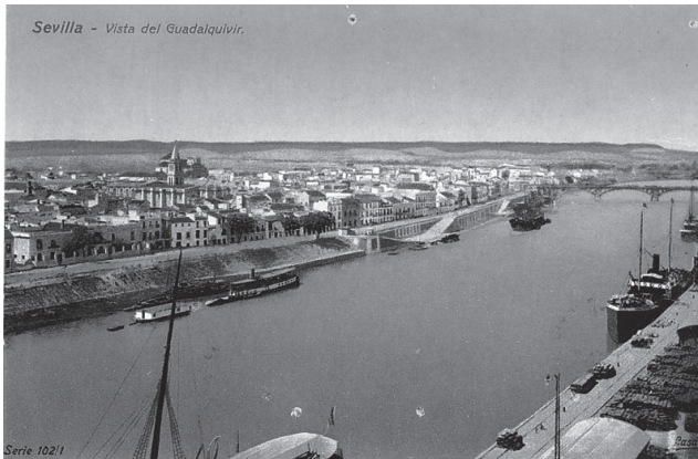
Figura 2. Vista del Guadalquivir, con la construcción del murallón en la orilla de Triana.
