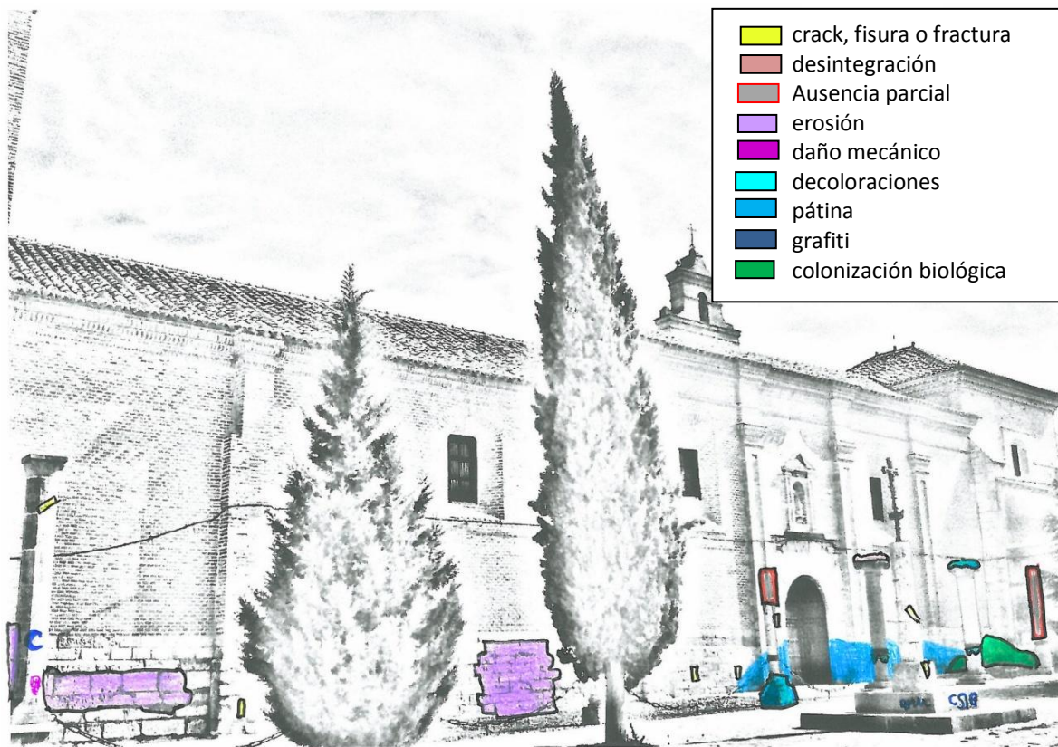
Fig. 4.124.. Fachada Real Monasterio de Santa Clara. Patologías presentes en el monumento
