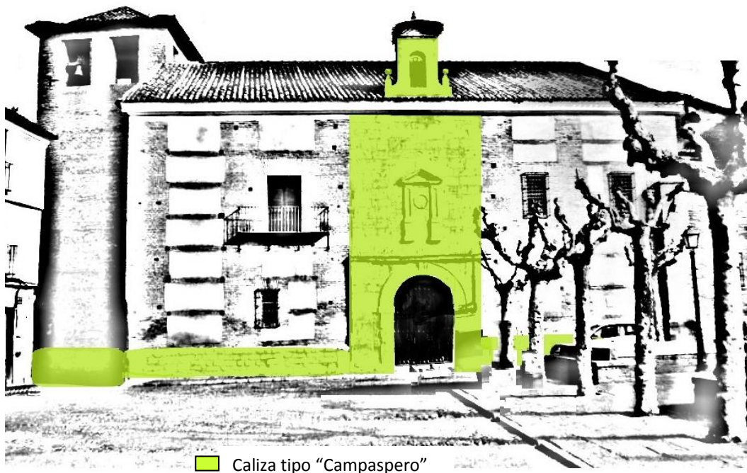
Fig 4.33. Alzado Sur iglesia del Santo Sepulcro. Litotipos utilizados en su construcción y restauración. a) Fachada del Santo Sepulcro b) Campanario en caliza c) Detalle sobre la portada principal
