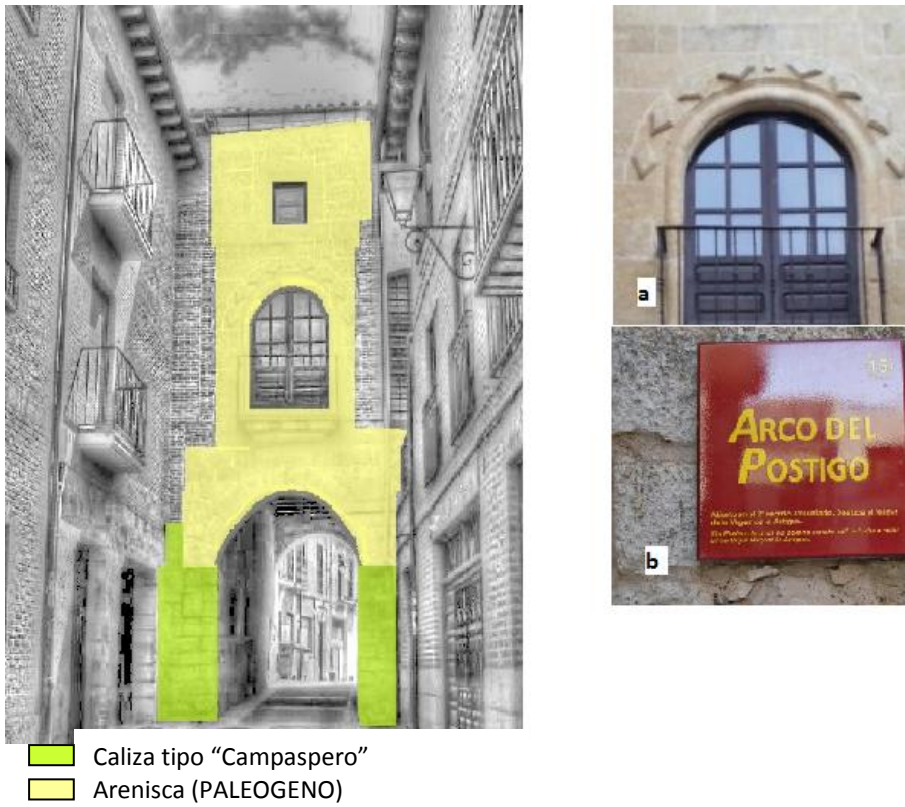
Fig.4.160. Puerta Sur Arco del Postigo. Litotipos utilizados en su construcción y restauración. a) Arenisca de la parte del balcón. b) detalle de la caliza de la parte inferior en la zona del cartel
