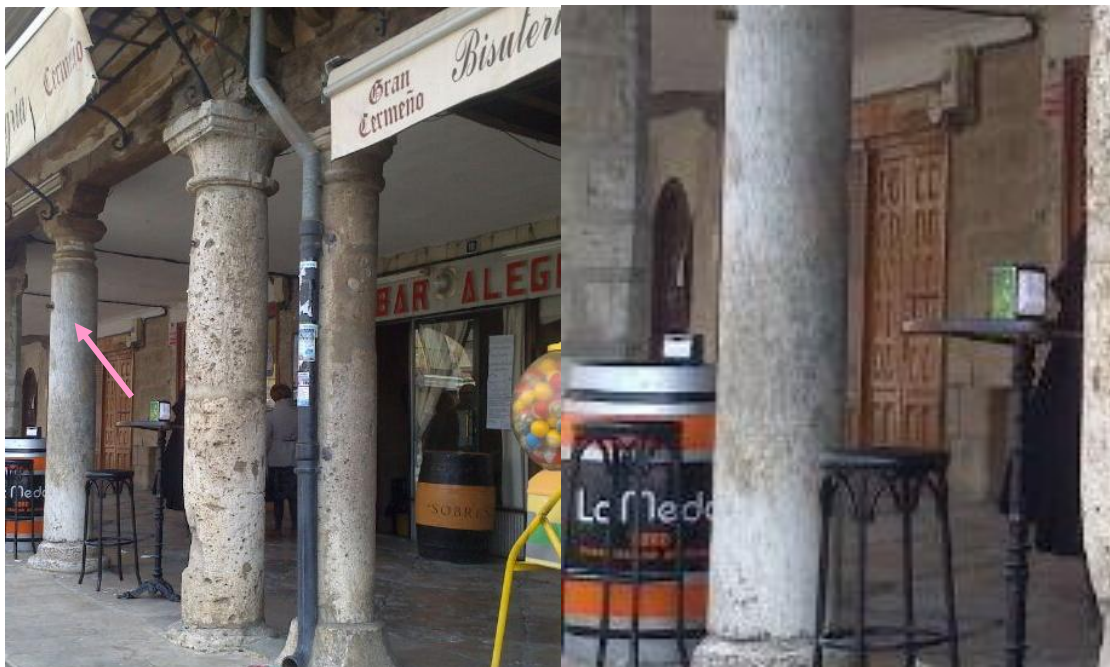
Fig.4.172a) Columnas de caliza junto a una de mármol b) Columna de mármol
