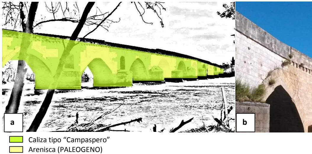
Fig 4.37. Alzado Oeste puente románico. Litotipos utilizados en su construcción y restauración. a) Esquema que destaca la caliza. b) Contraste de arenisca y caliza en el mismo ojo.
