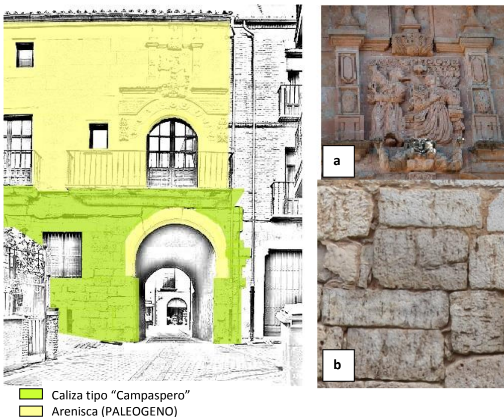
Fig.4.157. Puerta Sur Arco del Postigo. Litotipos utilizados en su construcción y restauración. a) Detalle en arenisca situado en la parte superior del balcón. b) caliza de la parte inferior
