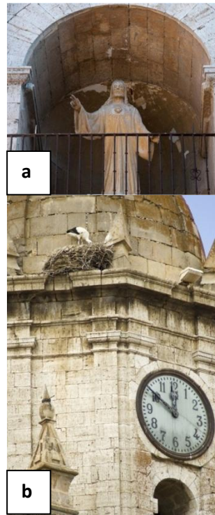
Fig. 4.165 Puerta Sur Arco del reloj. Litotipos utilizados en su construcción y restauración. a) caliza blanco-grisácea, muy compacta y algo oquerosa. b) la misma caliza de la parte superior
