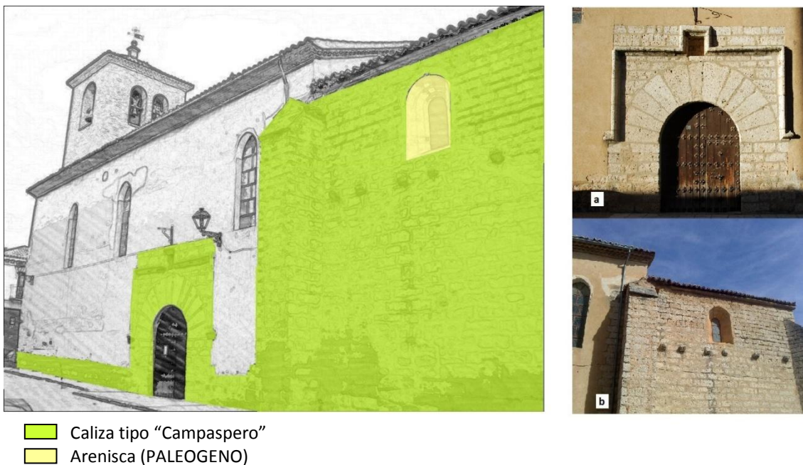
Fig.4.141 Alzado Este Santo Tomás Cantauriense. Litotipos utilizados en su construcción y restauración. a) Portada principal en caliza b) Ventana en arenisca
