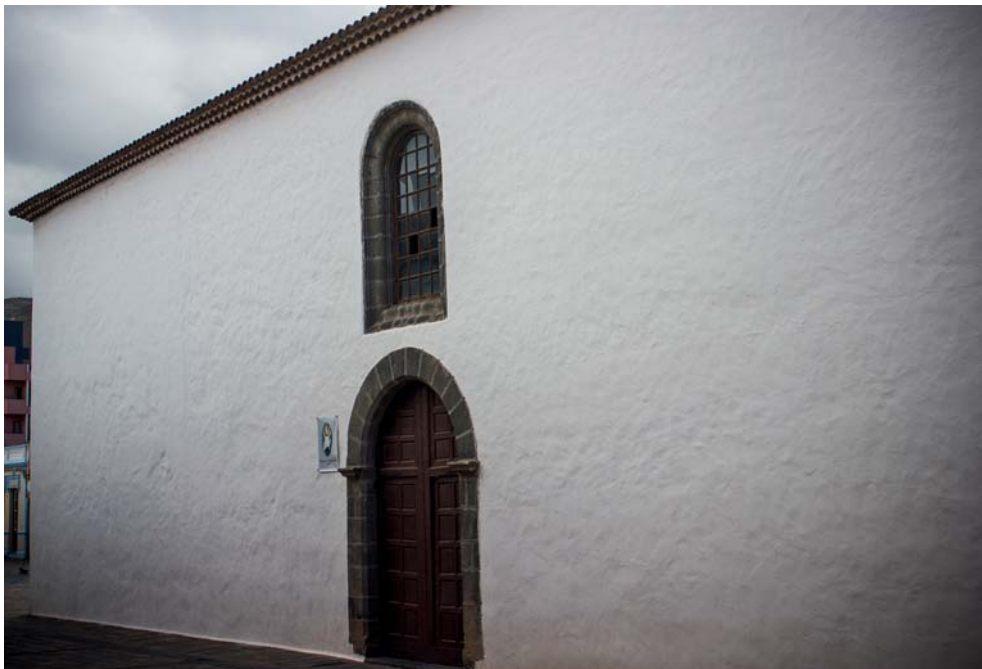
Fig. 13. Fachada lateral este.
