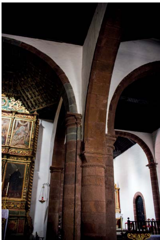
Fig. 20. Detalle del pilar del crucero.
