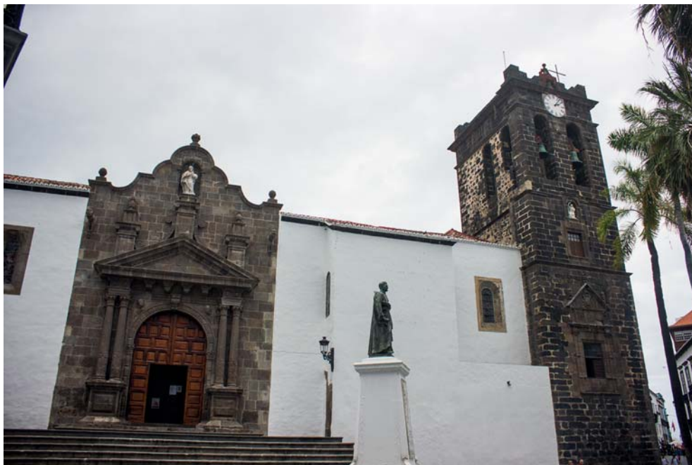
Fig. 25. Torre y fachada sur.
