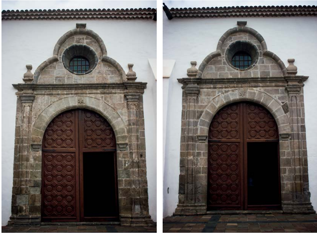
Fig. 14. Portadas de las naves laterales.
