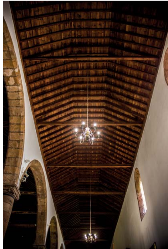
Fig. 10. Artesonado de la nave del Evangelio.
