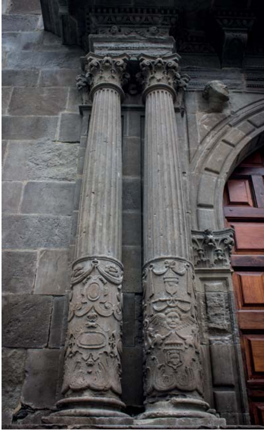
Fig. 27. Detalle de las columnas de la portada principal.
