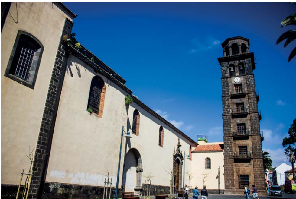
Fig. 1. Torre y fachada oeste.
