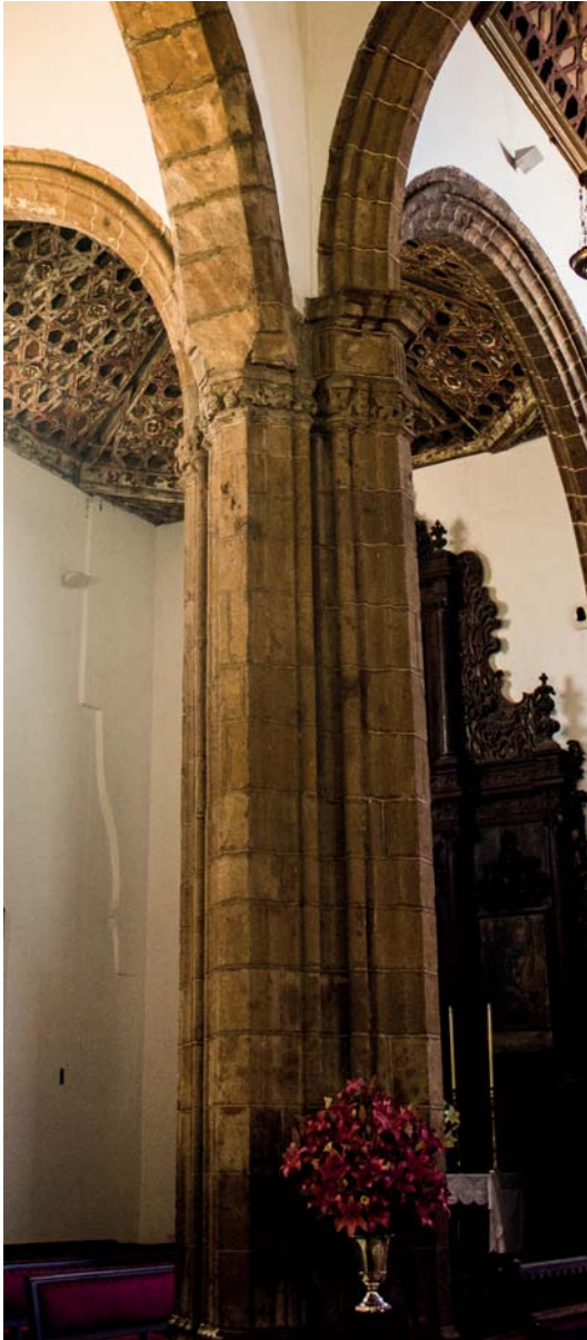
Fig. 9. Detalle del pilar del crucero.
