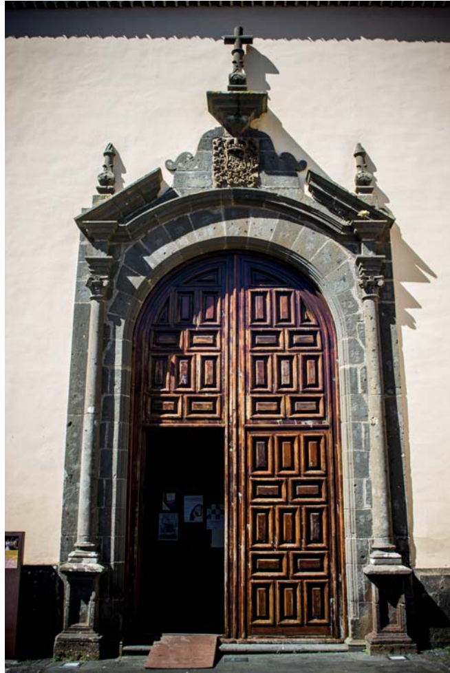
Fig. 3. Portada de la nave de la Epístola.
