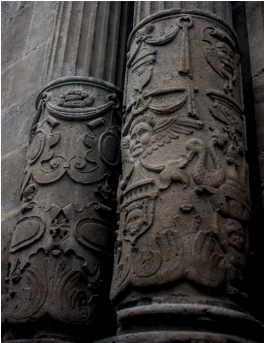
Fig. 28. Detalle de las columnas de la portada principal.
