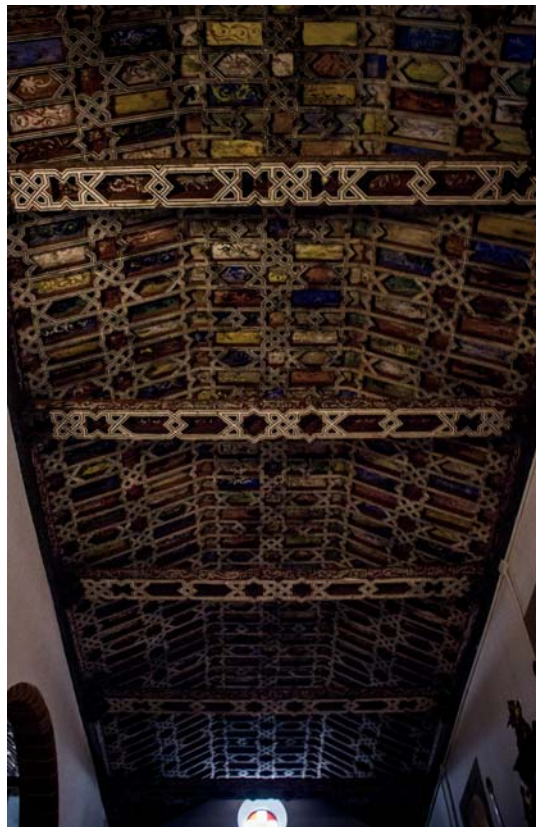
Fig. 40. Artesonado de la nave del Evangelio.
