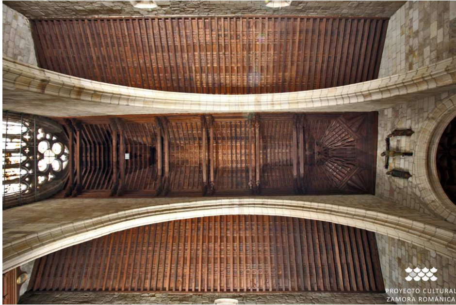
Figura 20: Iglesia de San Juan, en Zamora. Vista de los arcos formeros y la techumbre. Fuente: Proyecto cultural Zamora románica .
