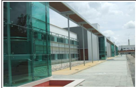
Universidad de Córdoba Recinto de Rabanales Edificio Ramón y Cajal
