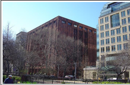
New York University Edificios Washington Square
