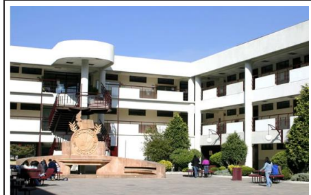
Instituto Tecnológico de Monterrey-ITESM Recinto de Toluca Edificio Preparatoria
