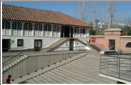
Pontificia Universidad Católica de Chile Recinto de Lo Contador Espacio central - grada
