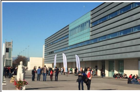
Universidad CEU-San Pablo Recinto de Montepríncipe Escuela Politécnica Superior – Vista general
