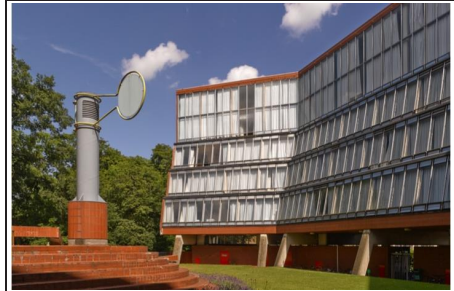
University of Oxford Edificio Florey
