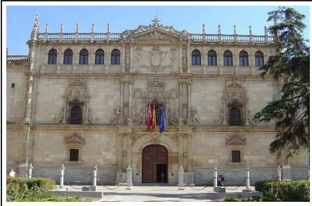
Universidad de Alcalá Recinto del Casco Histórico Colegio San Ildefonso - Fachada
