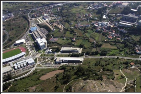
Universidade da Coruña Recinto de Elviña Vista general
