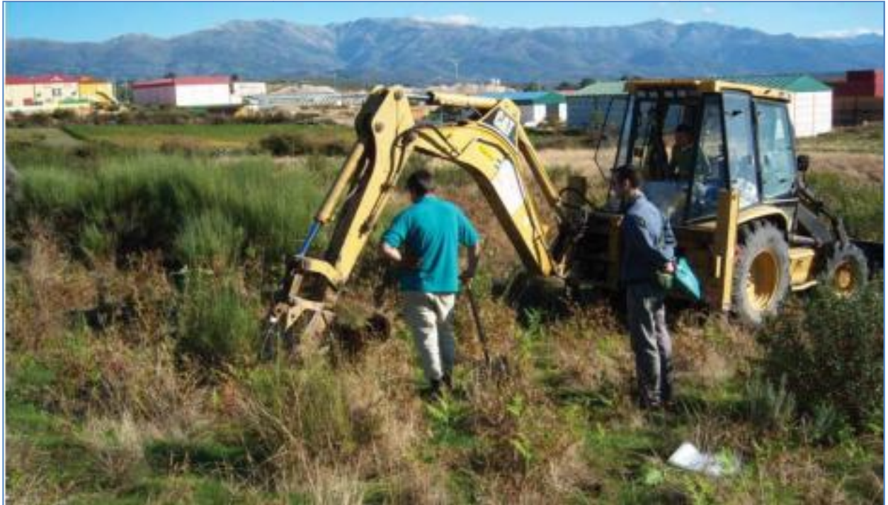
Fotografía 5: Detalle de la realización de la calicata C-1. Al fondo de la imagen se pueden ver otras naves industriales existentes en las inmediaciones.
