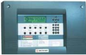
Ilustración 22: central detección
