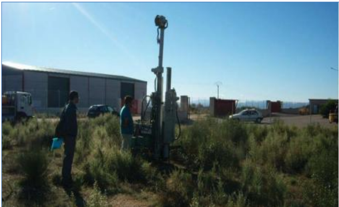
Fotografías 3 y 4: Imágenes de la máquina durante la realización del ensayo de penetración (DPSH) P-1. Al fondo de la segunda imagen se aprecia la existencia de naves de tipología similar a la proyectada.
