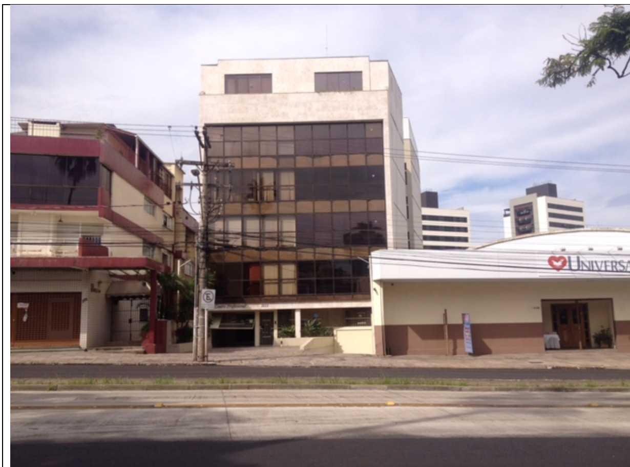
Fachada e vista das adjacências do escritório do Bairro Petrópolis
