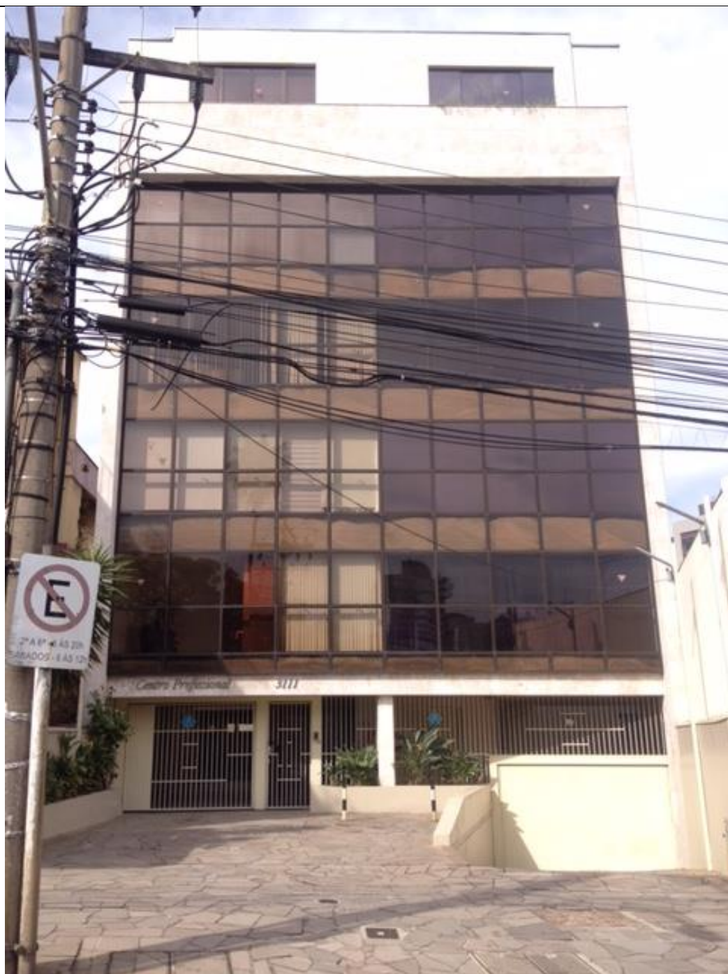
Prédio de Edifícios do Bairro Petrópolis
