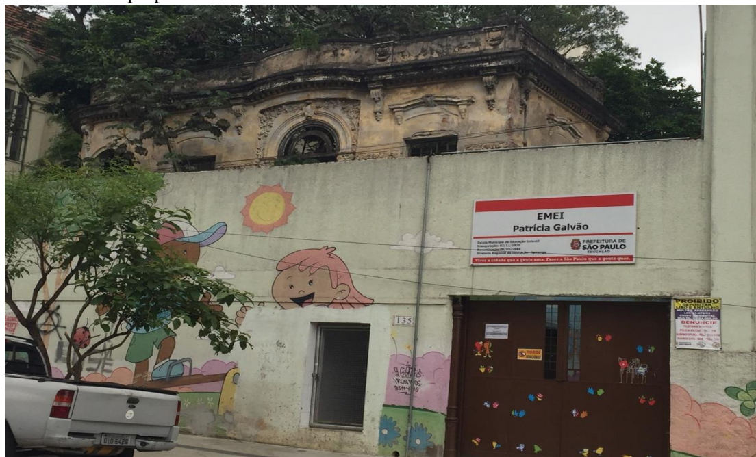
Fotografia 7: Edifício Antigo aparentemente abandonado. Praça Franklin Roosevelt – São Paulo. Fonte: Autoria própria.
