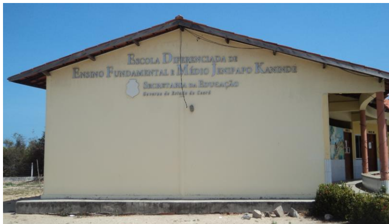
Figura 5. Fachada da lateral, espaço central para atividades culturais e fachada do ginásio coberto da Escola Diferenciada de Ensino Fundamental e Médio Jenipapo Kanindé. (Escola Indígena).
