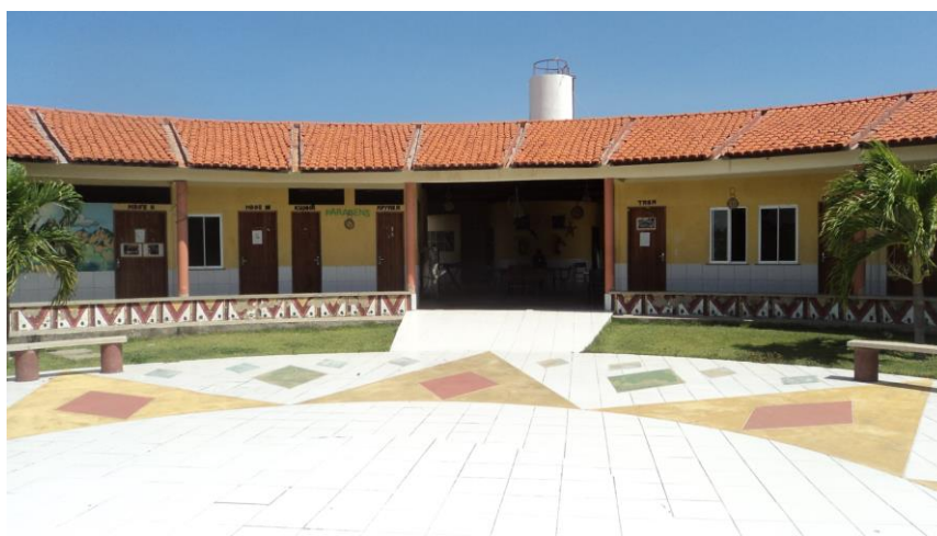
Figura 5. Fachada da Escola Diferenciada de Ensino Fundamental e Médio Jenipapo Kanindé. (Escola Indígena)
